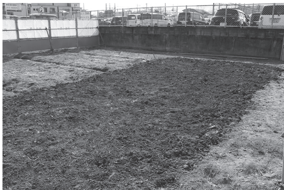
図8 2区埋戻し終了状況(北東から)
