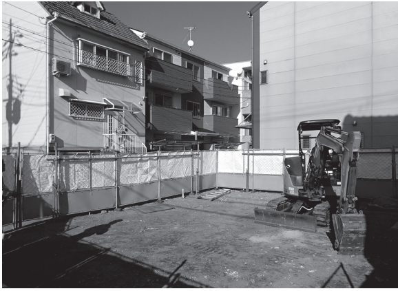
図2 調査前全景（南西から）
