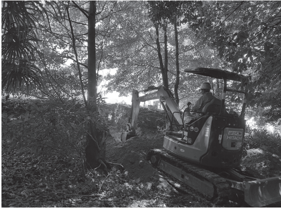
図2 3区重機掘削風景（南東から）
