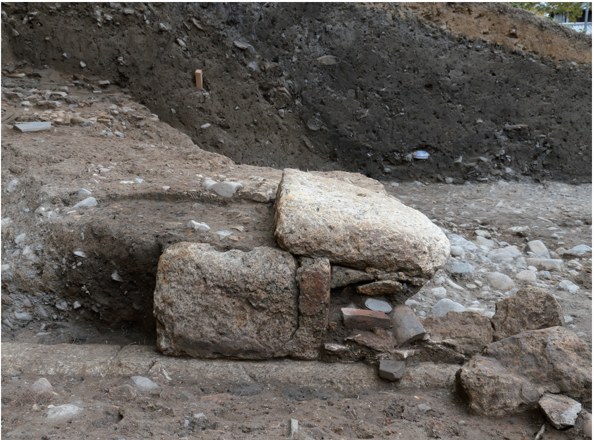
2 講堂北軒廊東縁基壇外装（東から）
