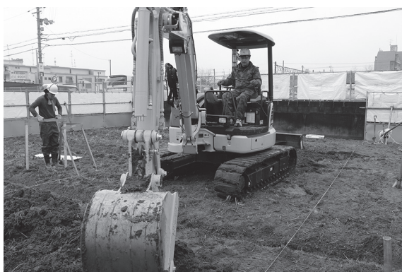
図6 2区重機掘削(北東から)
