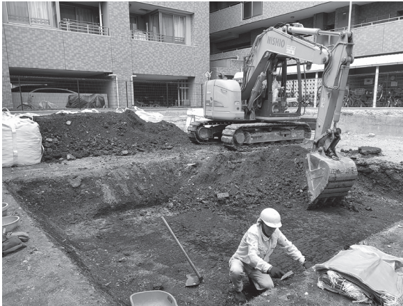
図2 重機掘削風景（南西から）
