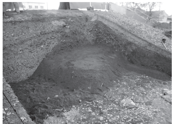
図6 真砂土養生（北東から）
