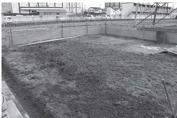
図7 1区埋戻し終了状況(北西から)
