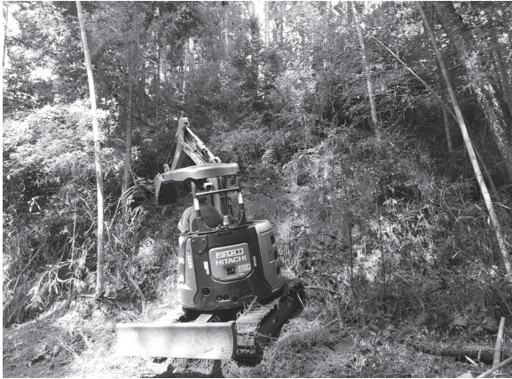
図4 4区重機掘削風景（南東から）
