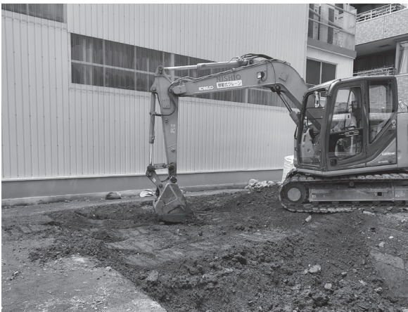
図6 埋戻し風景（南東から）
