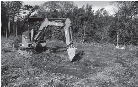
図3 機械掘削作業状況 (南西から)
