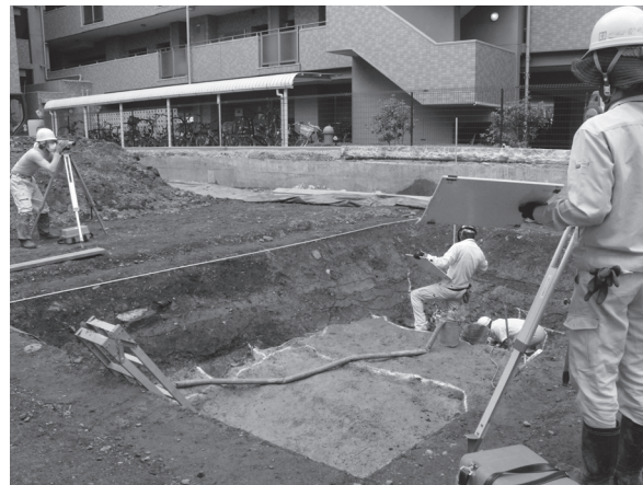
図5 測量風景（南西から）
