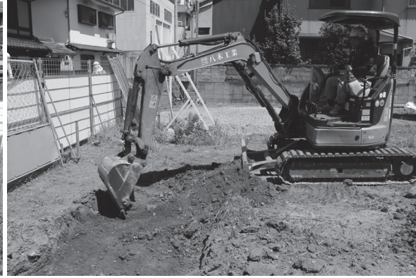
図3 重機掘削状況（南から）
