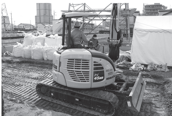
図5 1区埋戻し(北から)
