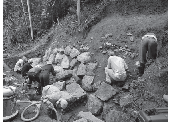
図5 4区作業風景（東から）
