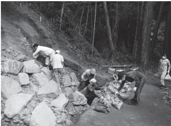
図8 4区土嚢養生風景（南西から）
