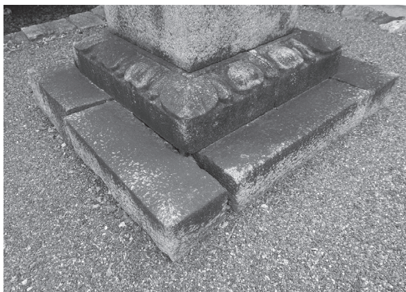
図 63 芝台の間隙（北東から）
