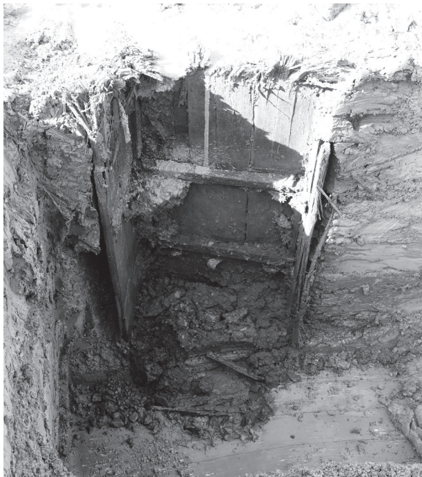
図77 井戸1断割り状況（東から）
