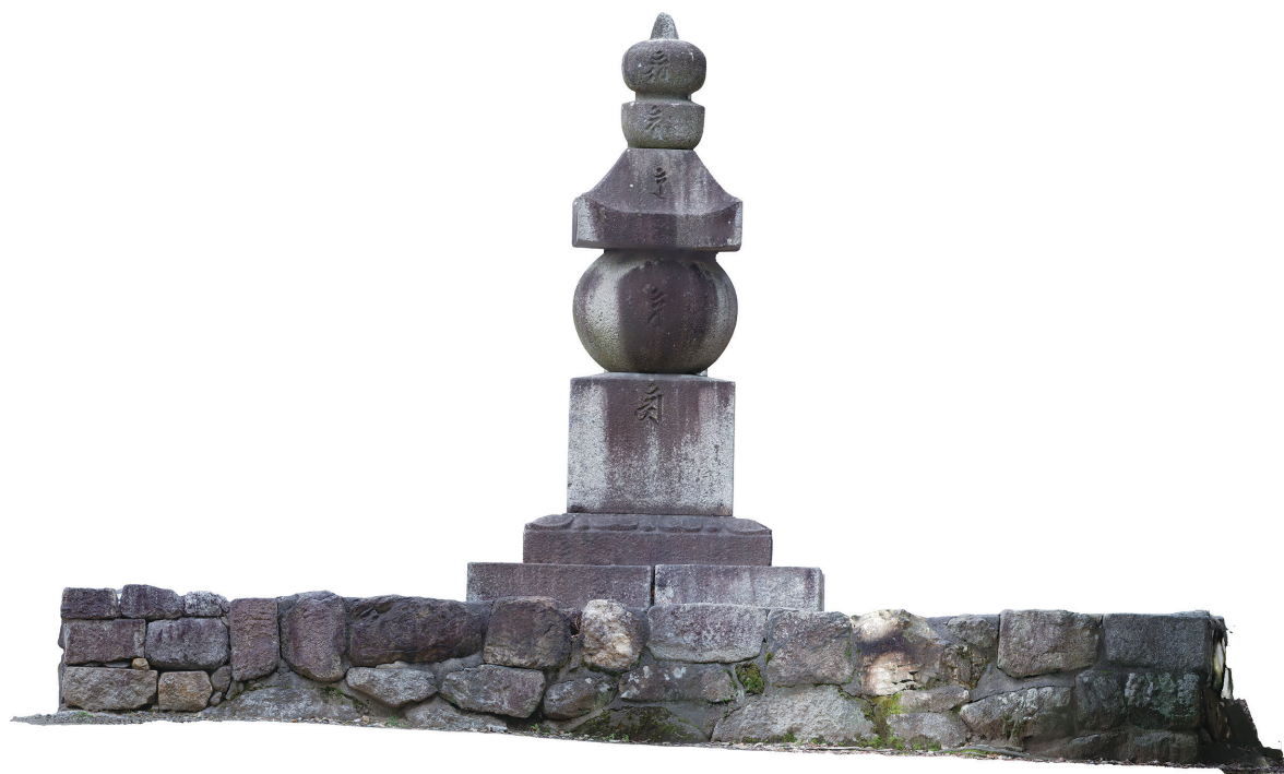
1 史跡方広寺大仏殿跡及び石塁・石塔、法住寺殿跡、六波羅政庁跡、方広寺跡（3N060）西面（修理前）
