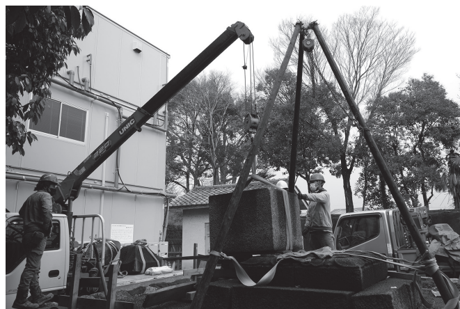
図 66 解体作業風景 (南から)
