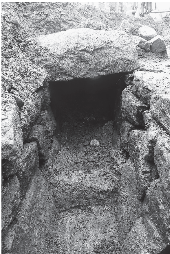
3 No.2地点 暗渠1 内部 (北西から)
