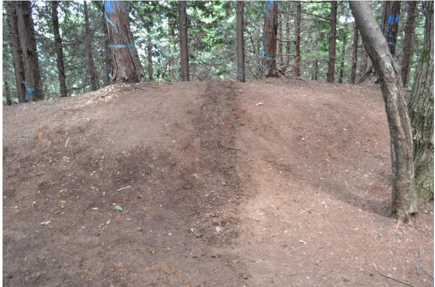
2 須川山砦跡 第7トレンチ（土壘） 埋戻し後の状況 西から
