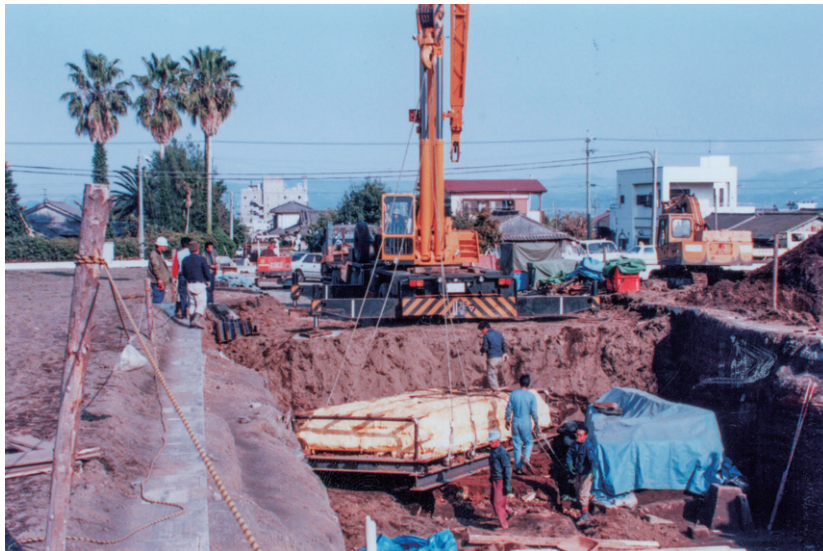
2 倒壊建物移設作業 2
