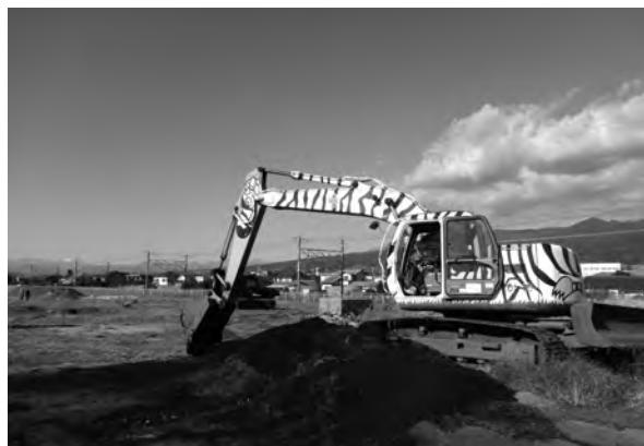
写真4 重機による埋戻し
