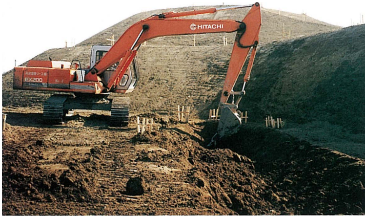
内堀の掘削状況 (西側くびれ部付近)
