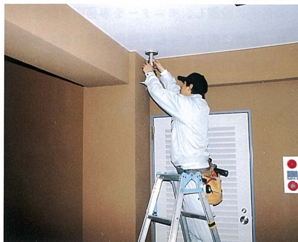
放送設備工事状況
