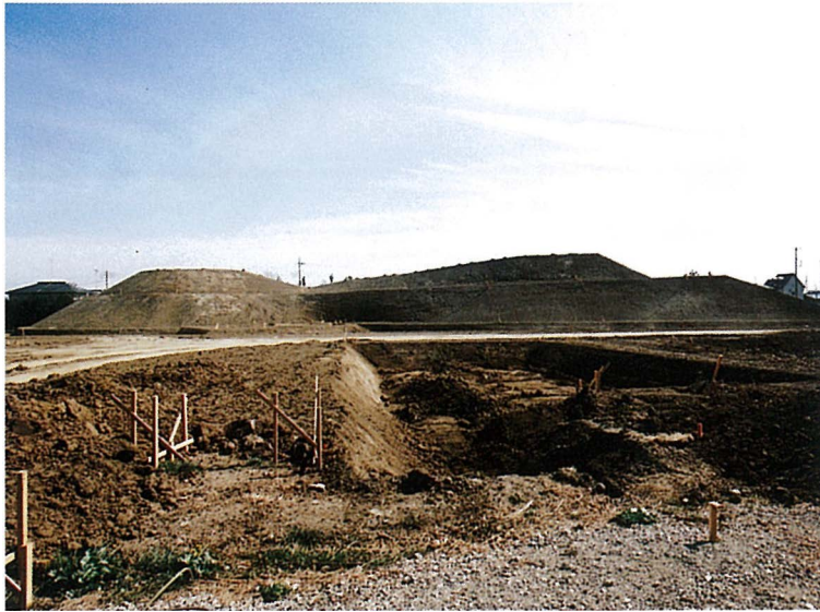
中堤造出し部分を復原する
