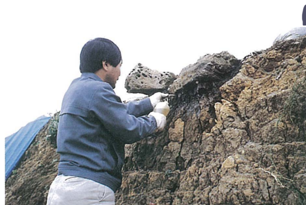
根石の下を補強する
