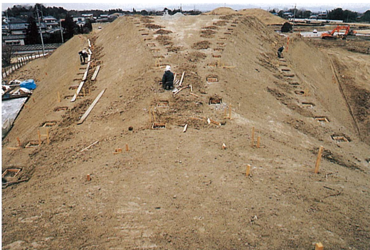
コンクリート用の木枠を取付ける
