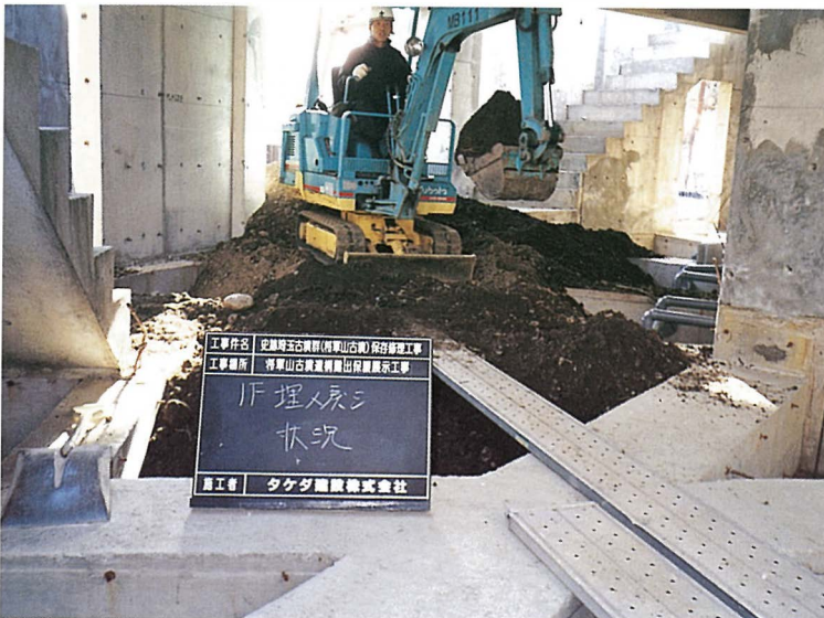
埋め戻し状況（1階床部分）
