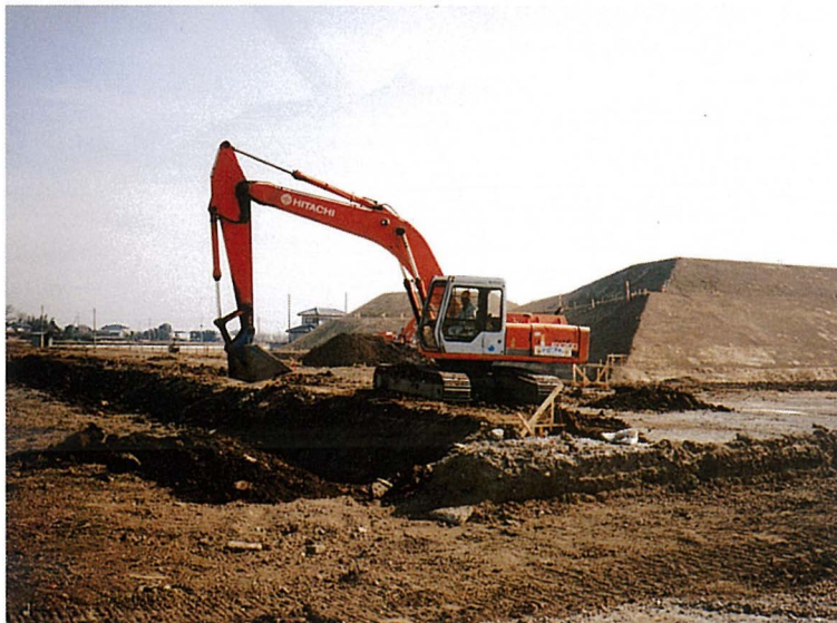
外堀掘削工事状況
