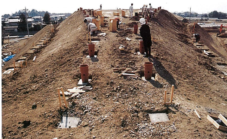
埴輪配列工事状況
