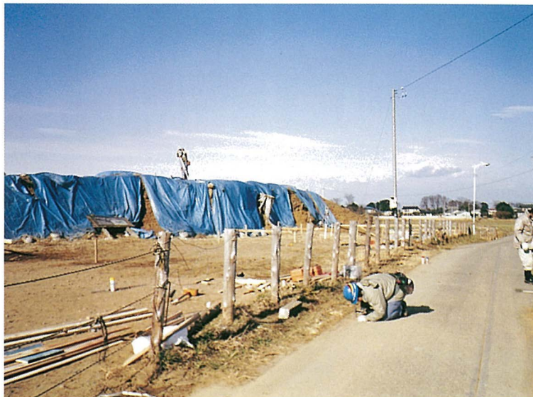
着工前の測量・位置出し
