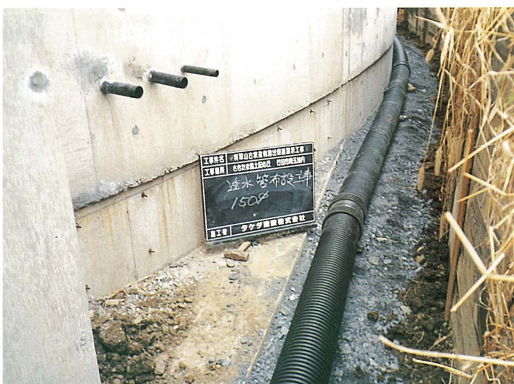
透水管布設工事
