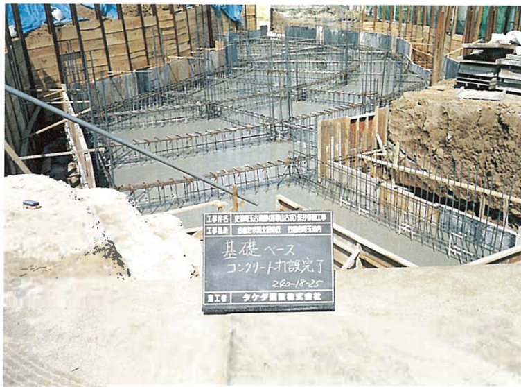
基礎ベース コンクリート打設完了
