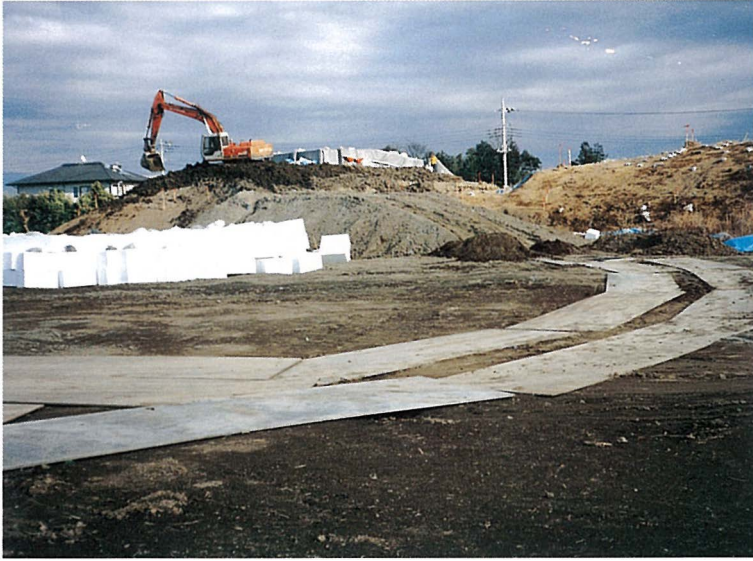
EPS工法による施工
