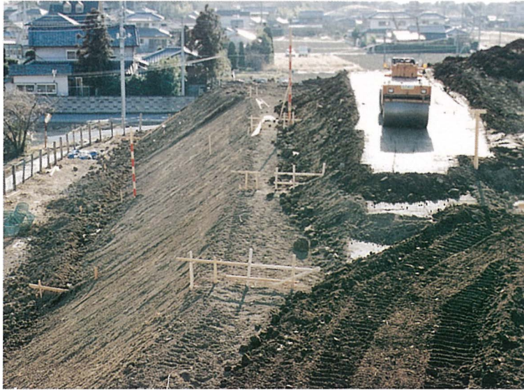
前方部 2 段目盛土転圧状況
