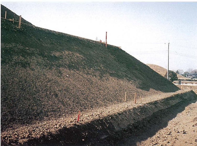
前方部法面の整形状況
