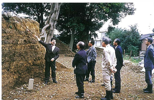
崖面土層の状況を視察 (H3)
