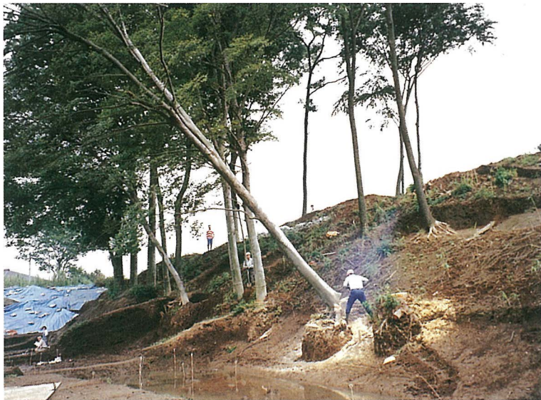
伐木施工状況
