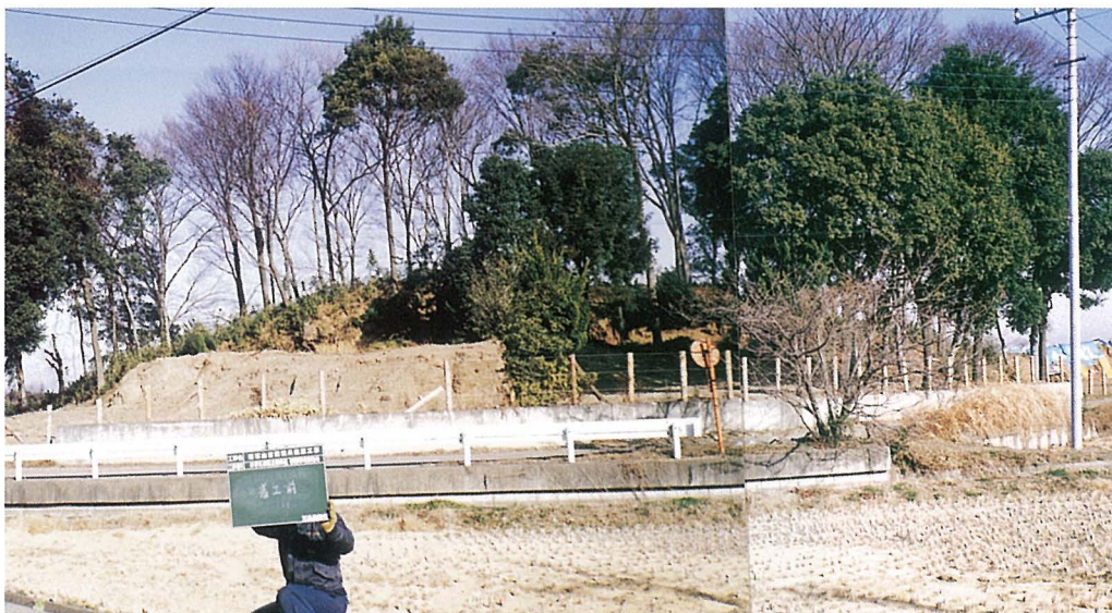
着工前の前方部
