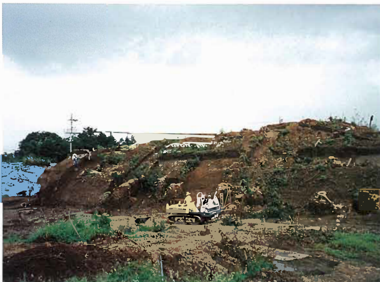
填丘すき取り工事（左後方）
