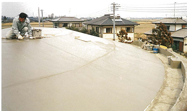
左官工事による仕上げ（屋根部分）
