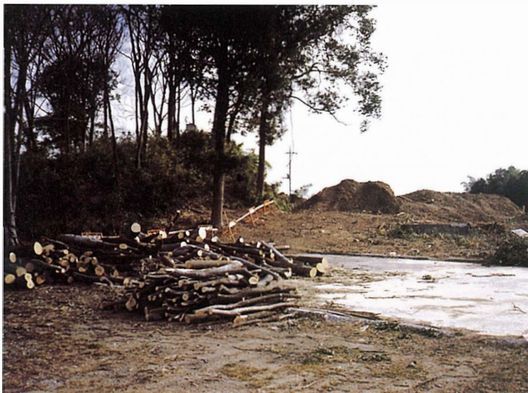
伐木施工状況
