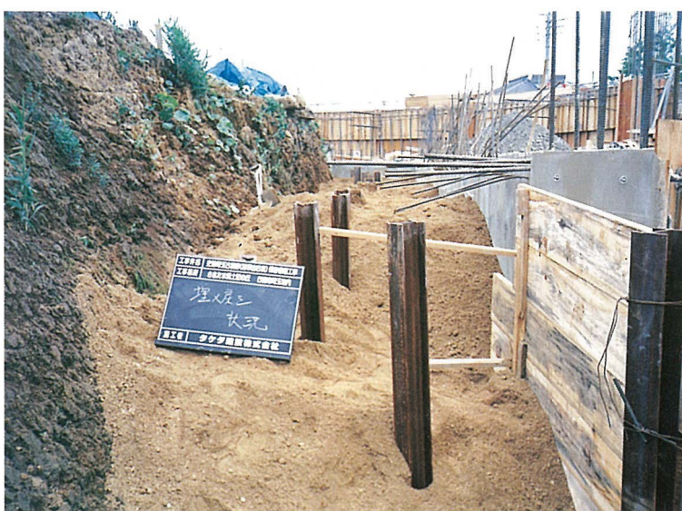
透水管埋め戻し状況
