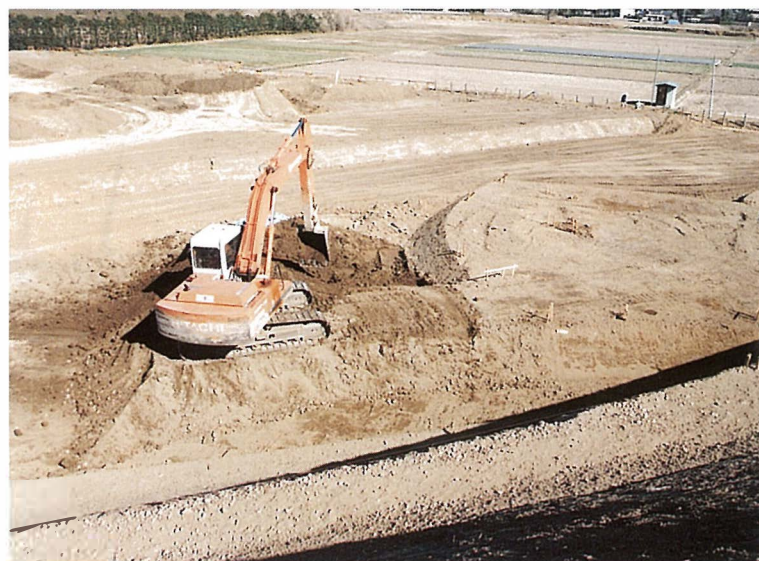
内堀の掘削状況(墳丘上から望む)
