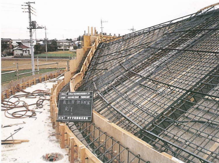
鉄筋配筋状況（屋根部分）
