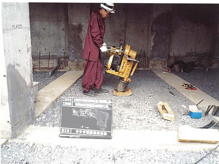
転圧状況（1階床部分）
