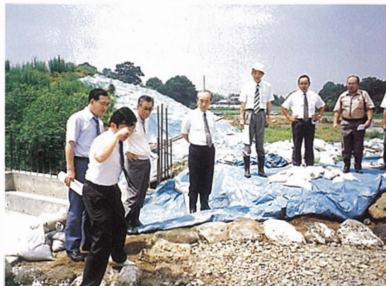
石室部分の工事状況を視察 (H6)
