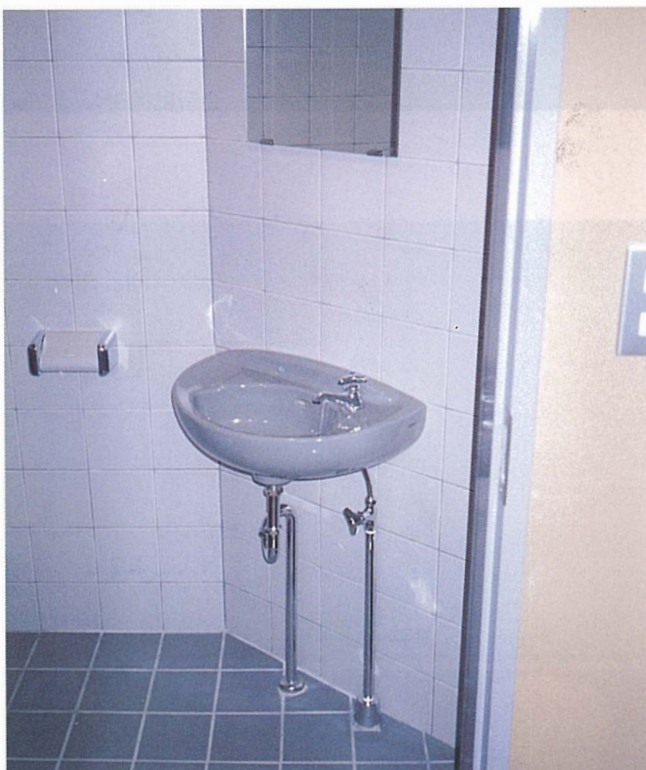
タイル貼り工事完了（便所内） 手洗器・鏡・便器取付完了（〃）
