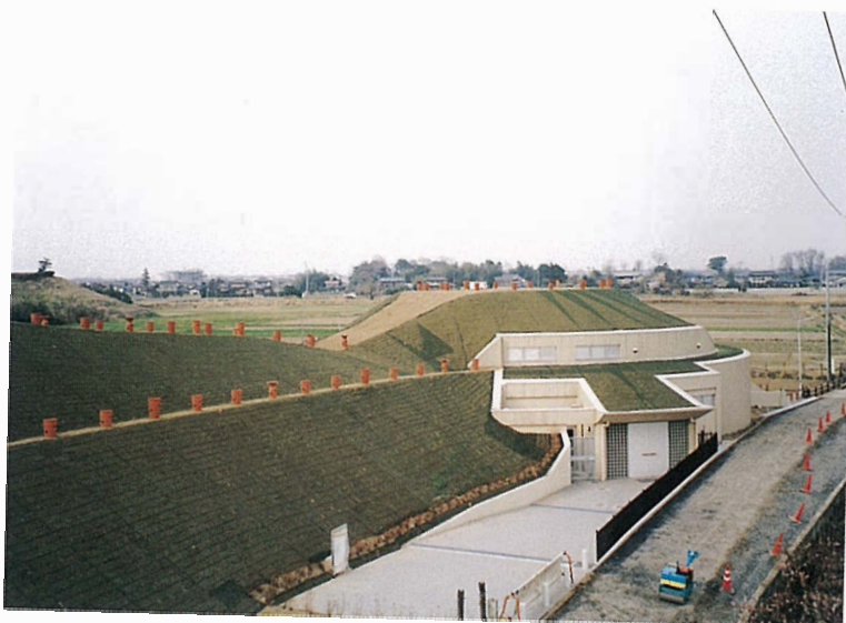
古墳展示館入口付近
