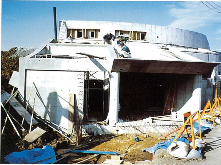
躯体工事中の施設外観
