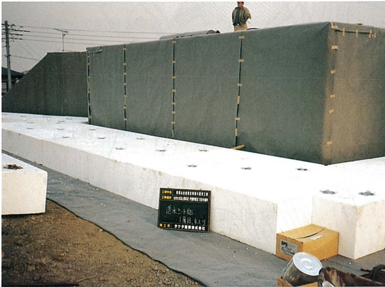
発泡スチロールブロックに 透水シートを貼る
