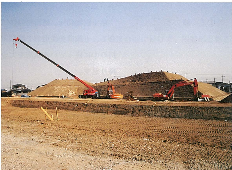
埴輪設置工事概観
