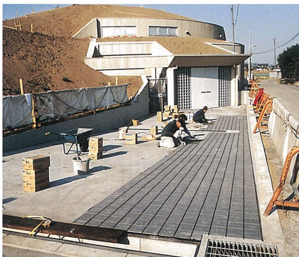
アプローチタイル貼り工事
