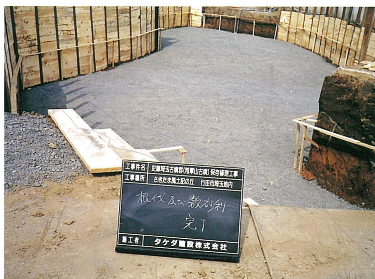
根伐後、敷砂利完了
