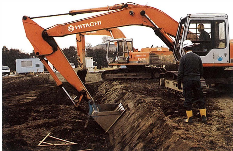
法面整地工事の状況
