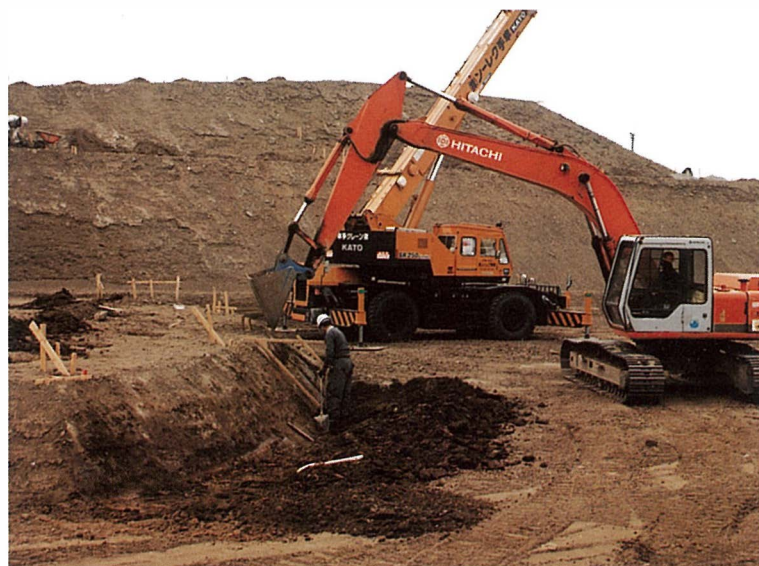
内堀の掘削状況(造出し付近)
