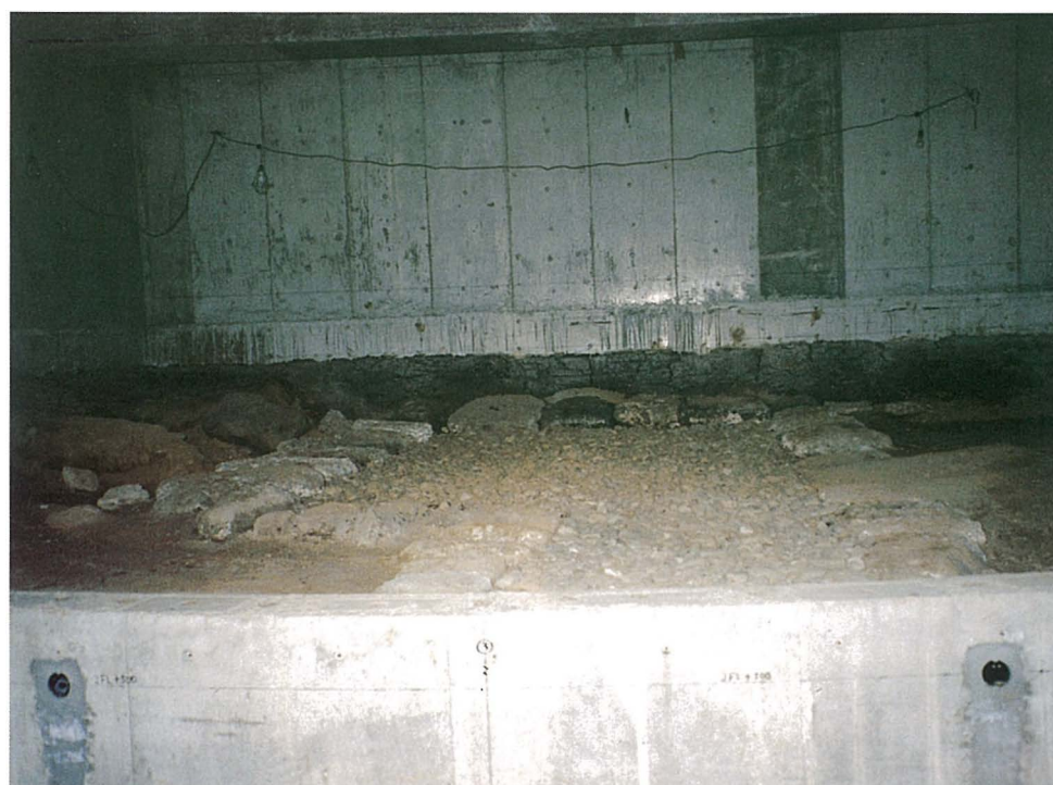
上：保存処理工事が終了した石室 下：石室を囲む覆屋（ガラスは未工事）
