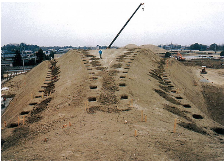
埴輪列に合わせて 各個に基礎を設ける
