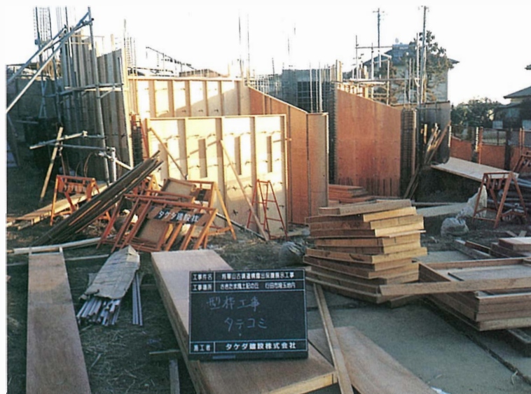
型枠工事建て込み状況
