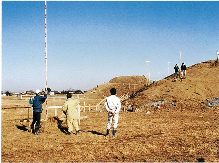
平成8年度 盛土工事前の測量
