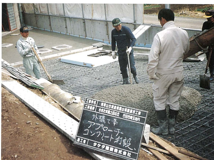
外構工事の状況（アプローチ部分）
