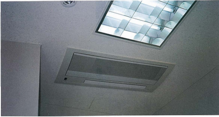
空調設備・照明器具取付（事務室）
