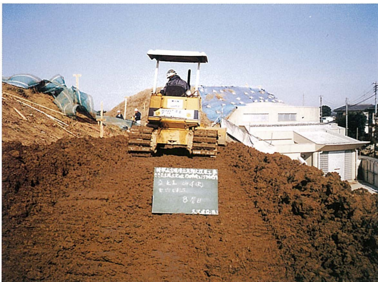
盛土工事転圧状況（8層目）
