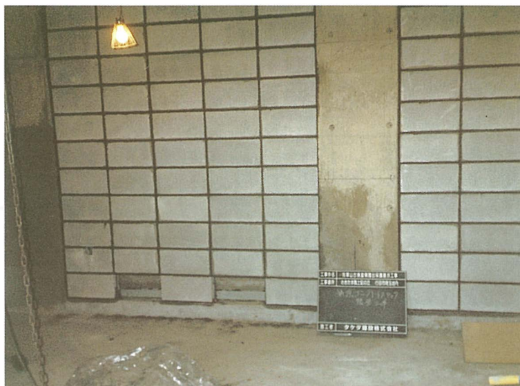
コンクリートブロック工事
