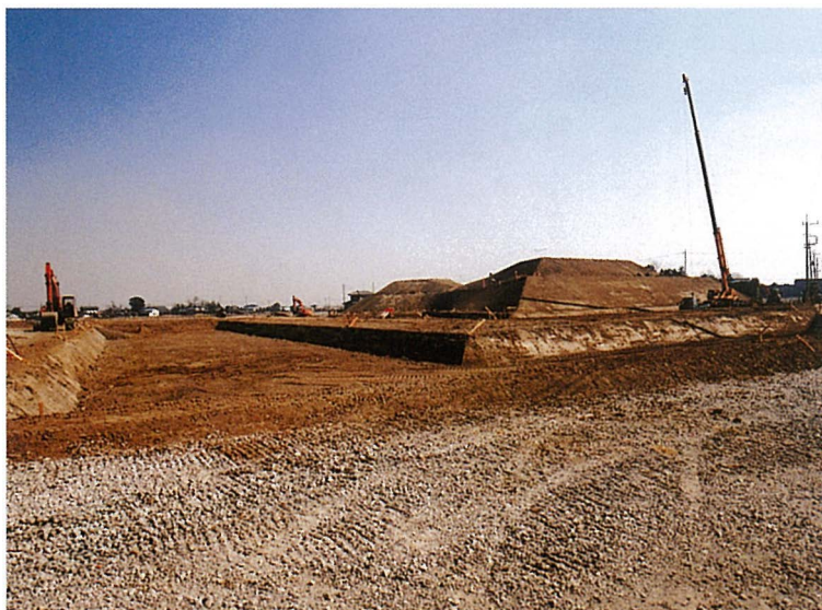
周堀実物大復原工事概観
