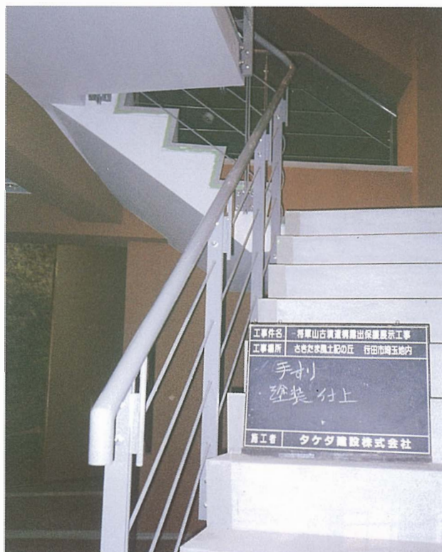
手摺部分塗装仕上げ完了
