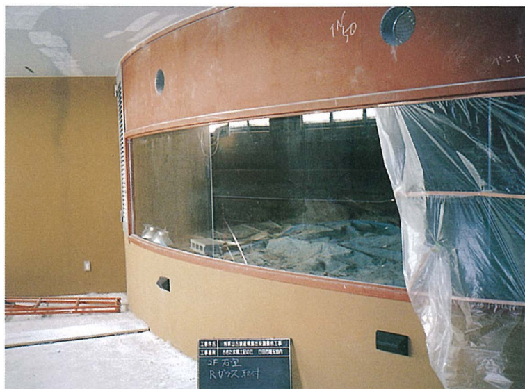
石室前面のガラス取付け
