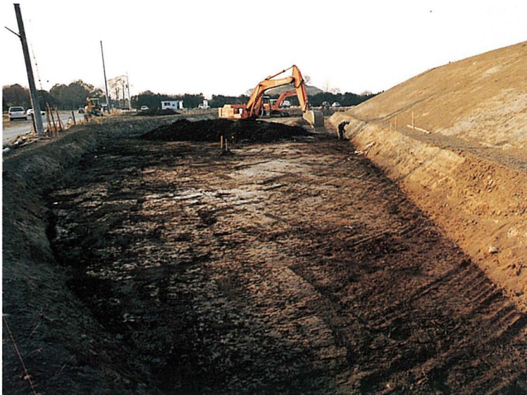
堀底のレベルを確認する
