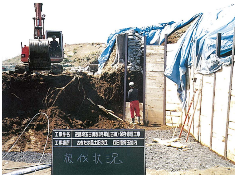
矢板による土留めと根伐状況
