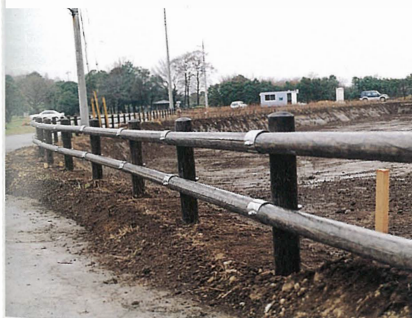
擬木柵の設置
