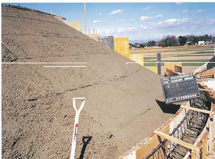
コンクリート打設完了（屋根部分）
