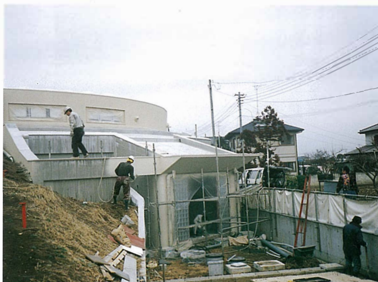
施設外壁塗装状況
