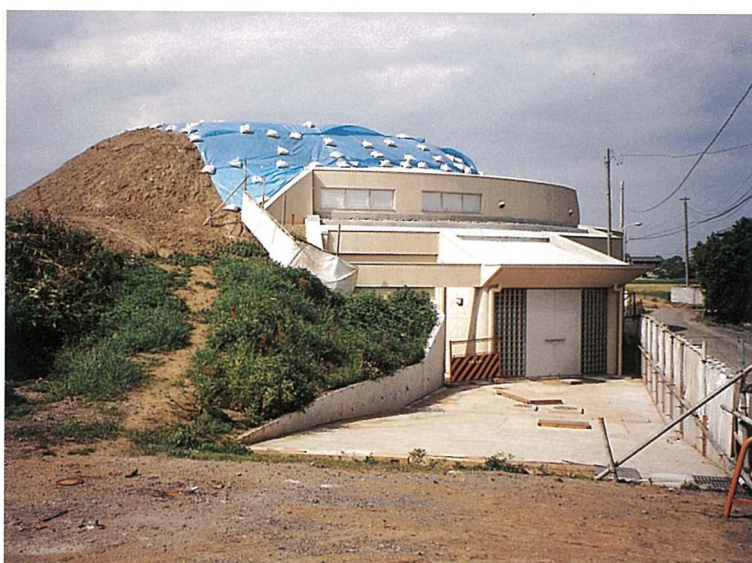
内装工事ほぼ完了の施設外観
