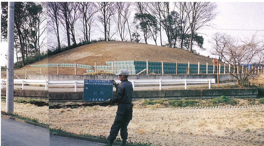
工事終了後の前方部
