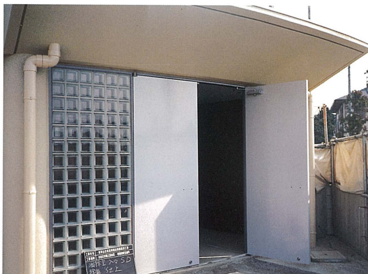
風除室入口ドア塗装仕上げ完了
