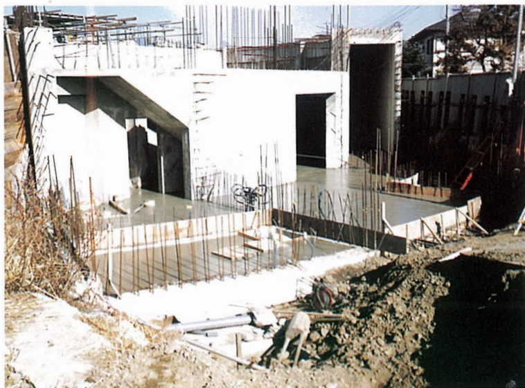
コンクリート打設状況（入口付近）
