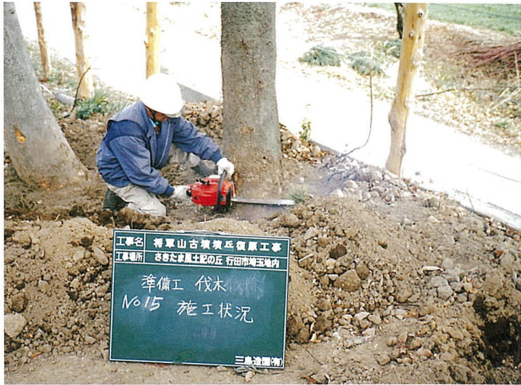
伐木施工状況
