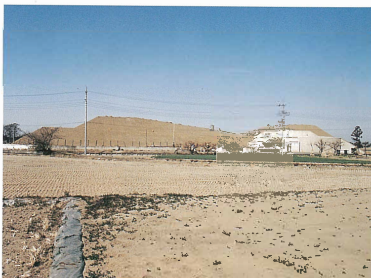
盛土工事完了（東側）
