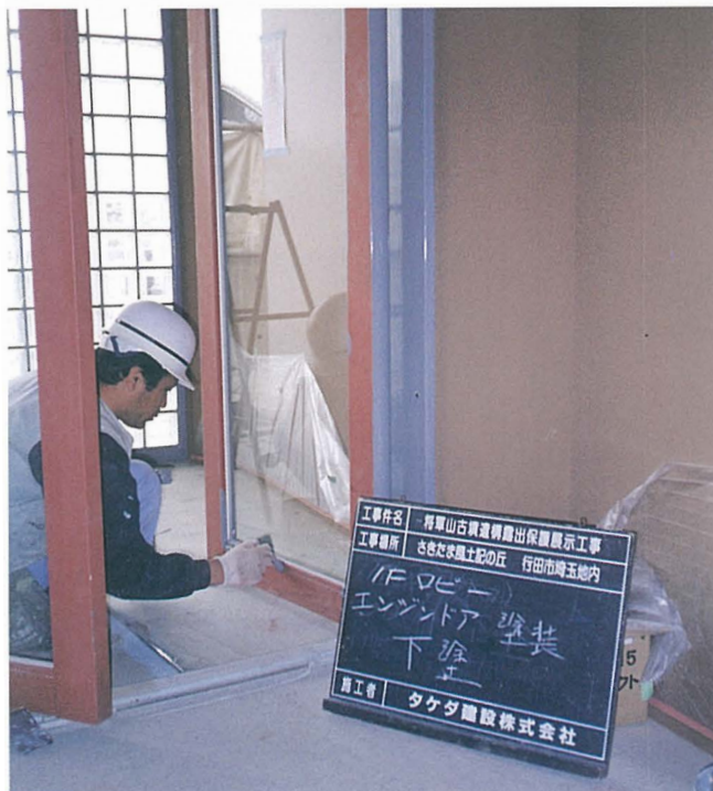
エンジンドア塗装（1階ロビー）
