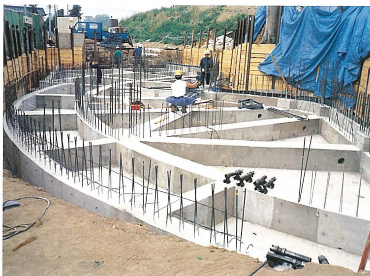
基礎ベース 型枠解体完了（地中梁）
