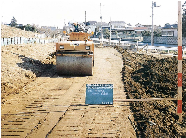
盛土工事転圧状況（4層目）
