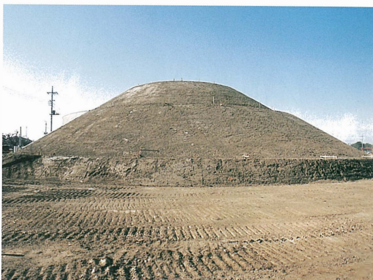
後円部盛土工事完了
