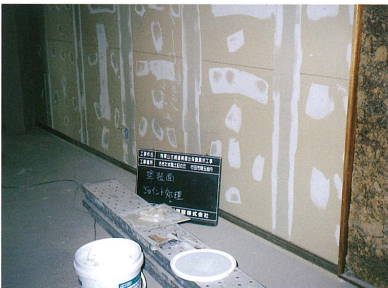
内壁吹き付け下地処理（一階）
