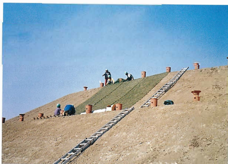
植生ネット張付け状況
