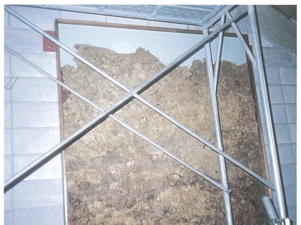
土層パネル取付完了
