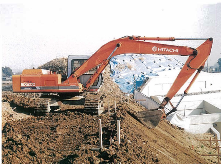
前方部1段目の法面整形
