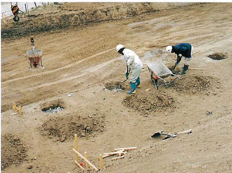
基礎用のクラッシャーランを敷く
