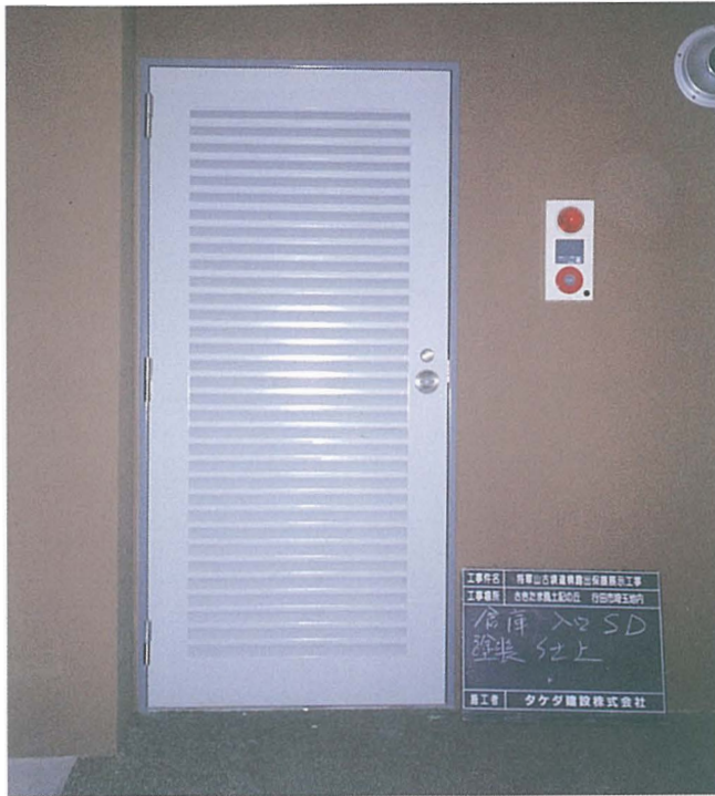
ドア等建具類の取付・塗装状況
