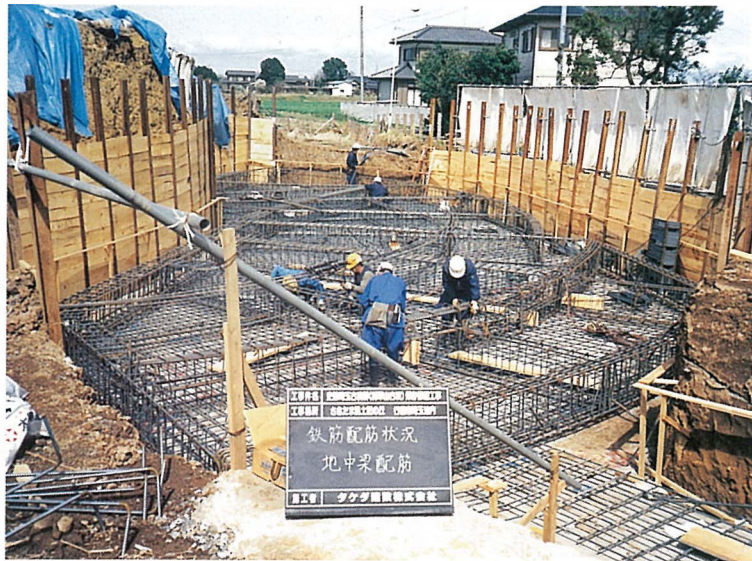
鉄筋配筋状況（地中梁）
