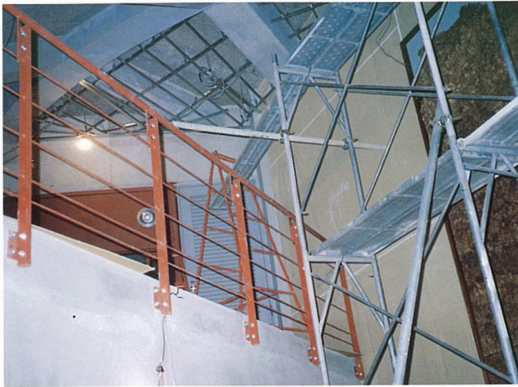
手摺取付け完了（2階・吹抜け）
