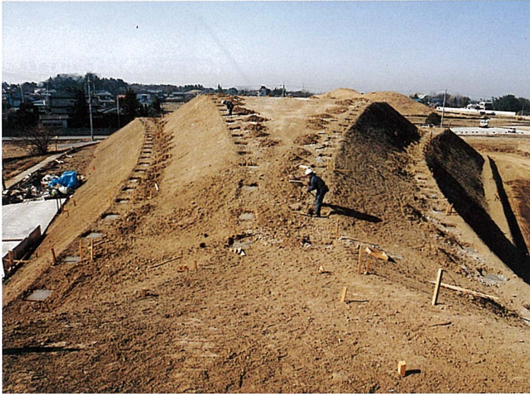
コンクリート基礎設置状況
