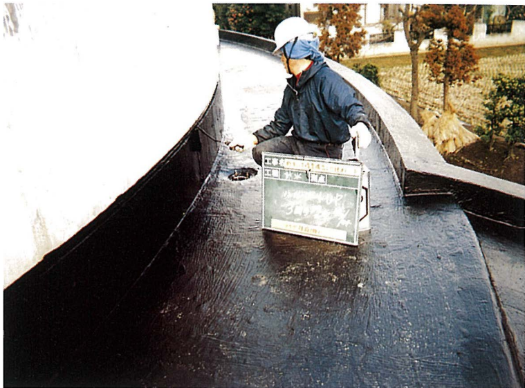
防水工事 ハルコート塗布（屋根部分）
