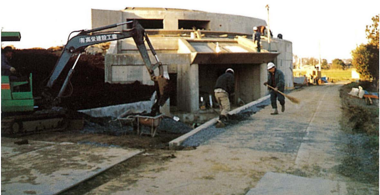
施設は半地下構造となっている
