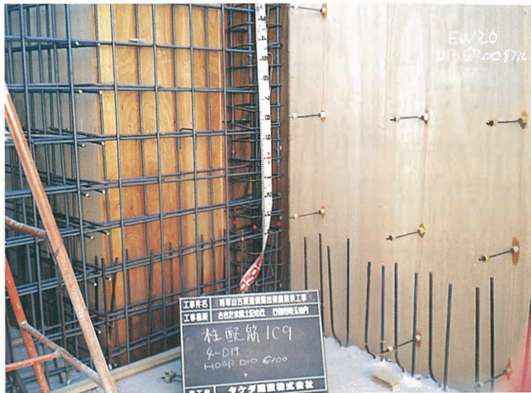
鉄筋配筋状況（柱）
