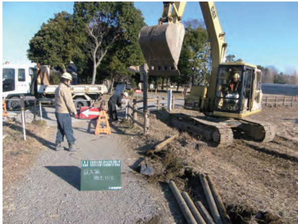
施設撤去工（擬木柵撤去）
