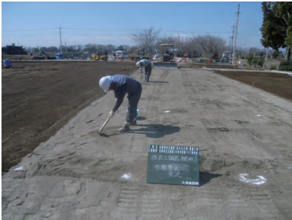
復原整備工（改良土不陸整正）
