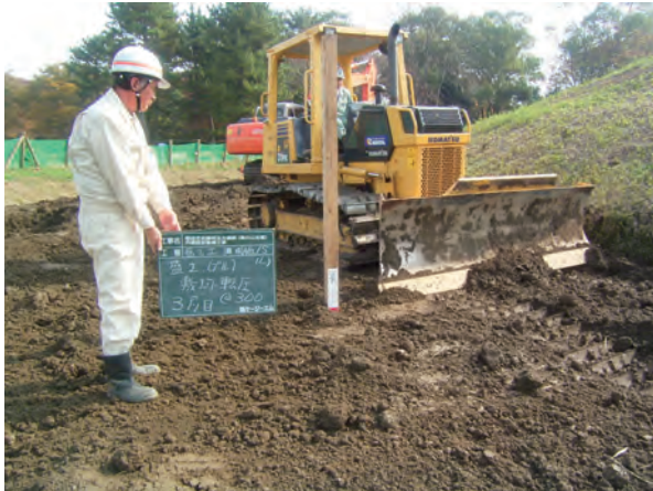
盛土工（敷均し・転圧）
