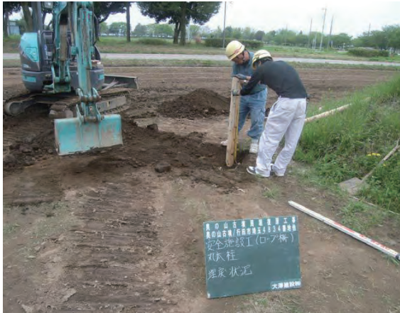
安全施設工（ロープ柵）
