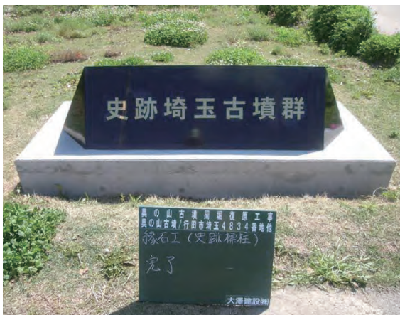
史跡標柱（完了）
