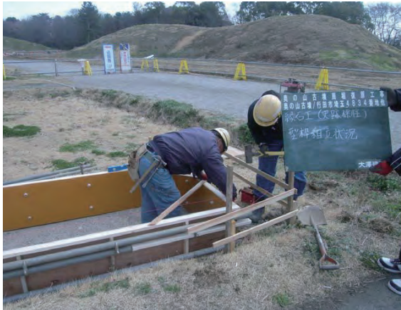
史跡標柱（型枠組立）
