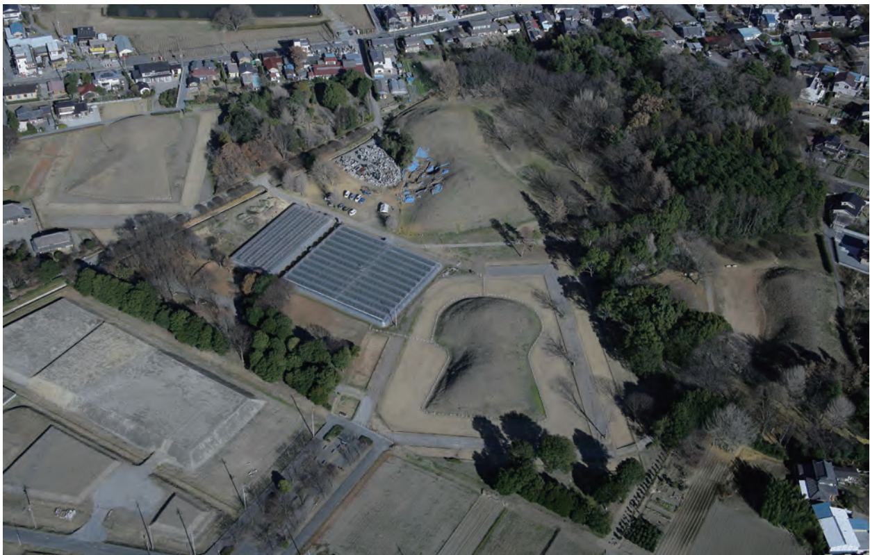
整備工事完成後の航空写真（1）
