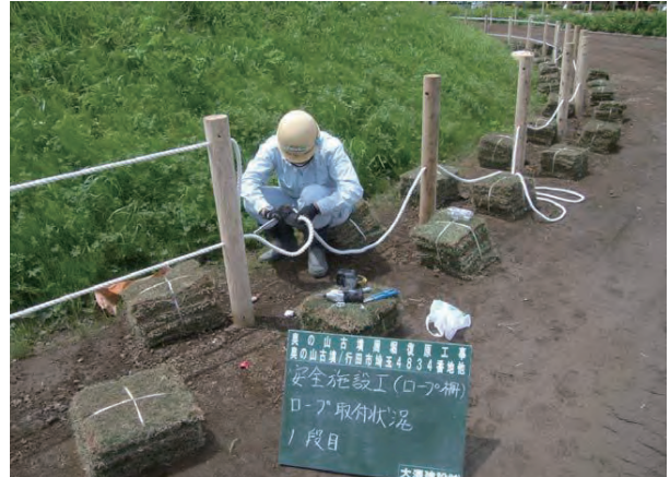
安全施設工（ロープ柵）
