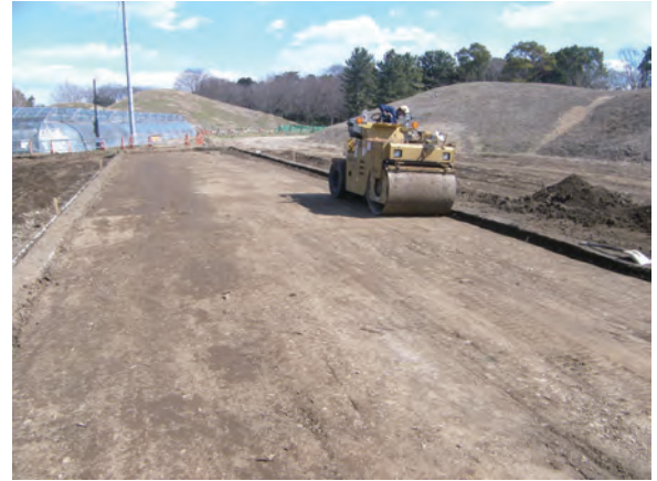
復原整備工（中堤路床転圧）
