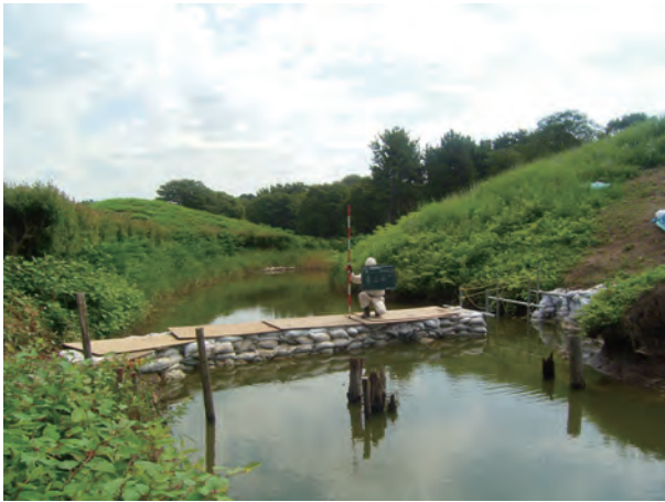
着工前（造出し部周辺）
