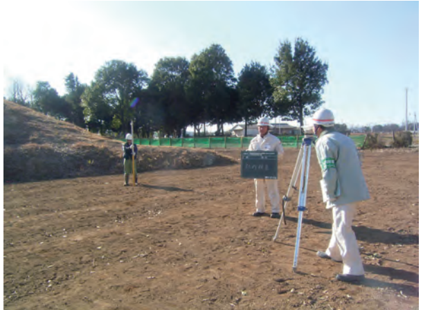
仕上げ高検査
