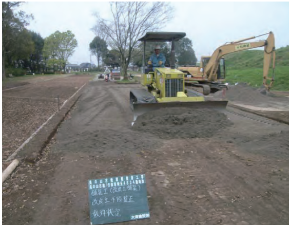
舗装工（改良土舗装）
