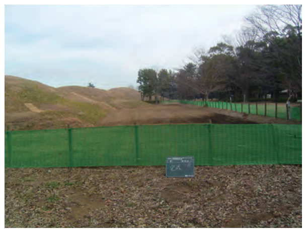
着工後（墳丘東側）
