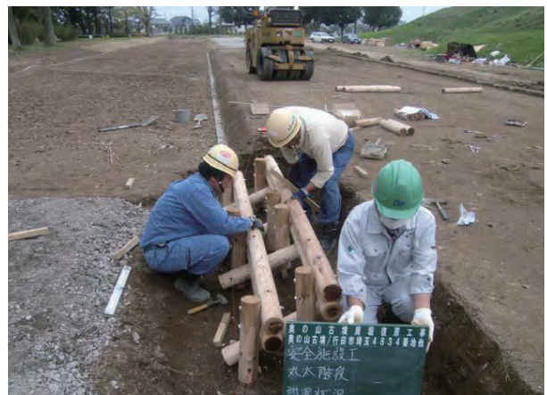
安全施設工（丸太階段）
