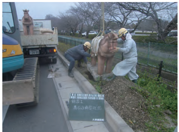
施設撤去工（オブジェ移設）
