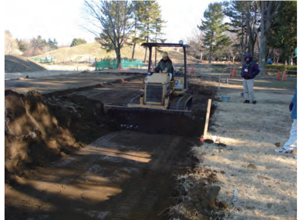
整地工（外堀部の整地）
