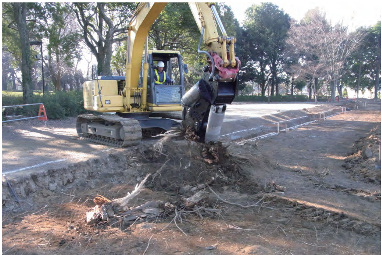
支障切株の除去状況 (切断用カッターで横に伸びた樹木根を除去)
