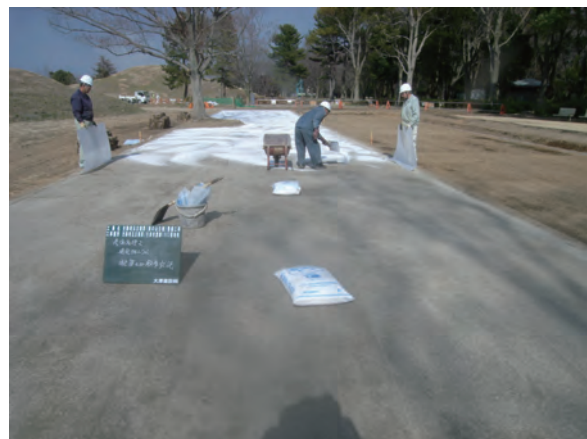
復原整備工（塩化カルシウム散布）
