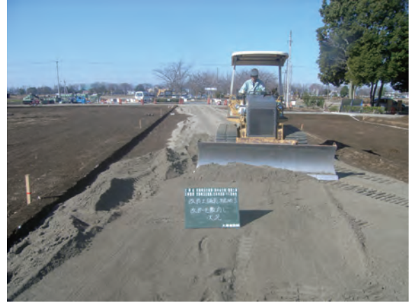
復原整備工（改良土敷均し）
