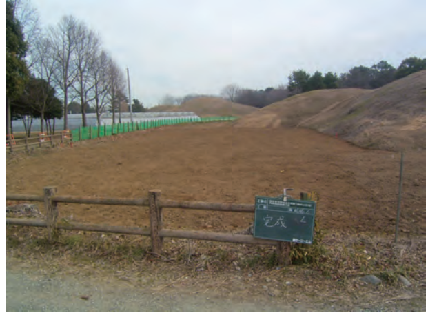
着工後（墳丘西側）
