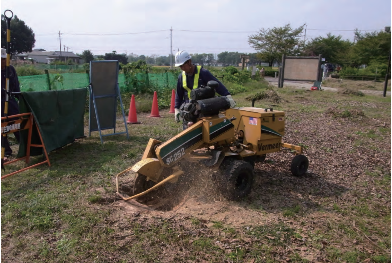
支障切株の除去状況 (掘削せずに切株のみを削る)
