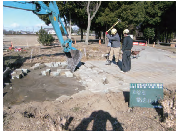
施設撤去工（大谷石撤去）
