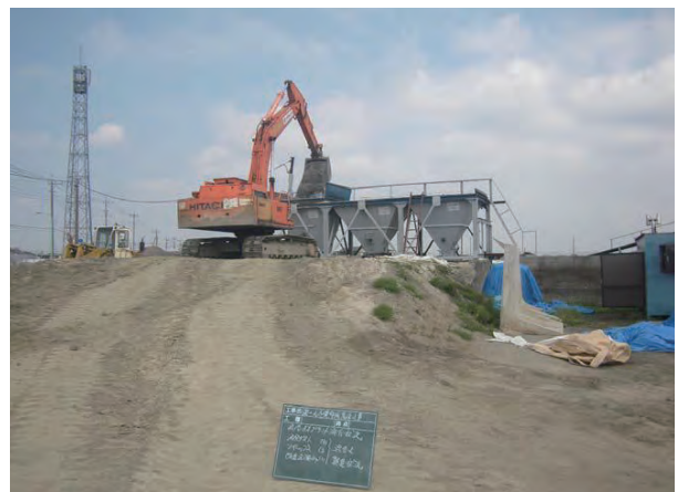
舗装工（改良土混合状況）
