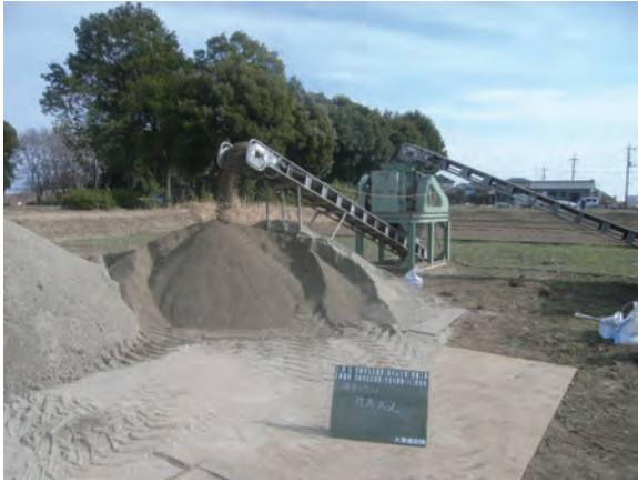
復原整備工（プラント稼働状況）
