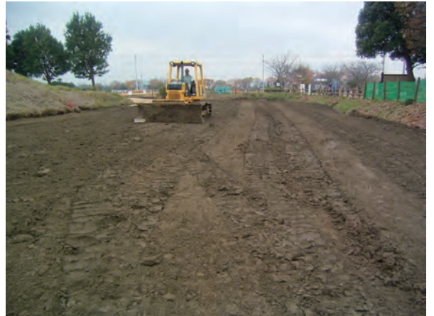
盛土工（敷均し・転圧）
