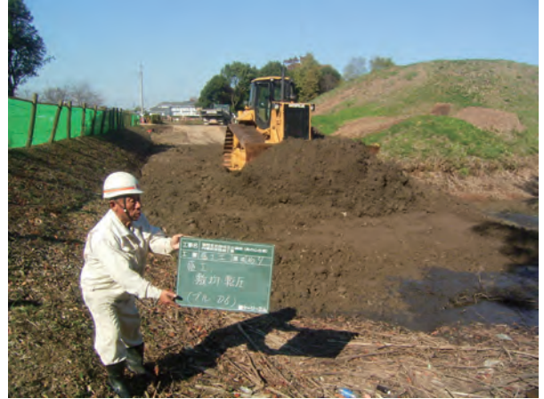
盛土工（敷均し・転圧）
