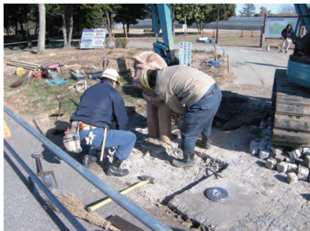
施設撤去工（オブジェ撤去）
