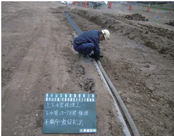
上下水道保護工
