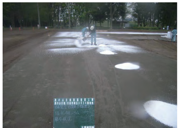
舗装工（塩化カルシウム散布）
