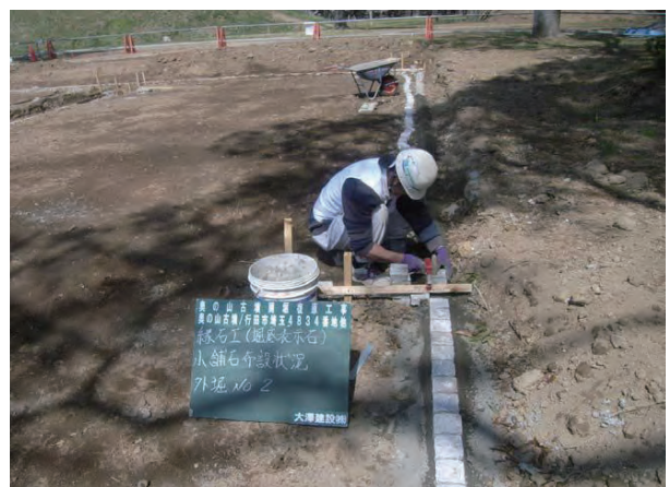
縁石工（堀底表示石）
