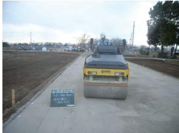
復原整備工（改良土転圧）
