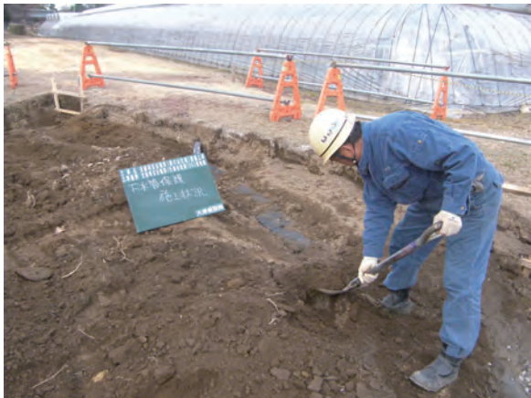
整地工（下水管保護）
