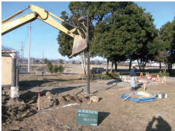
施設撤去工（園路灯撤去）
