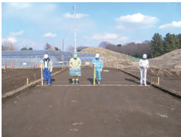
復原整備工（中堤路床完成）
