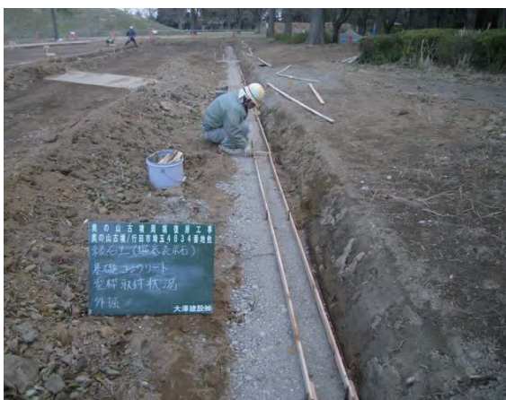
縁石工（堀底表示石用基礎コンクリート）
