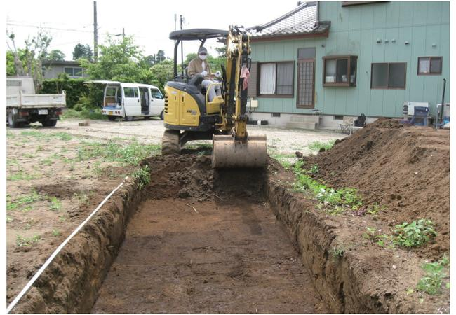
2. 重機による掘削状況 (北西→)
