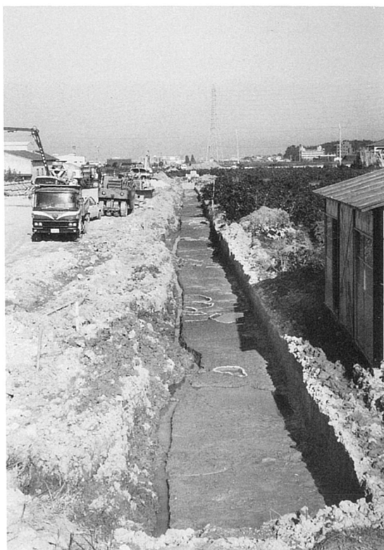
A地区東側擁壁部全景（南から）
