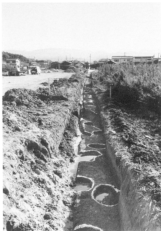
A地区西側擁壁部全景（北から）
