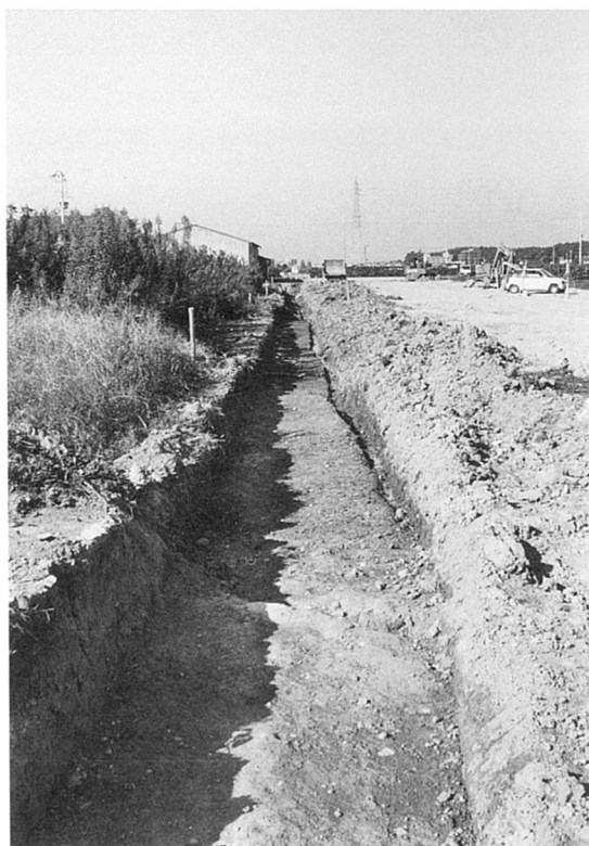
A地区西側擁壁部全景（南から）
