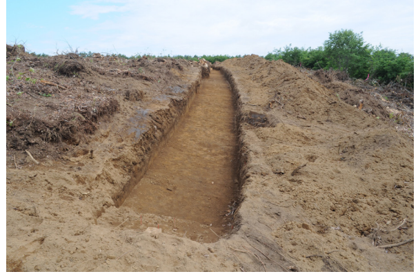
Aトレンチ（南から）
