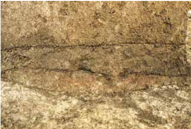
ℓ 8 赤変状況断面
