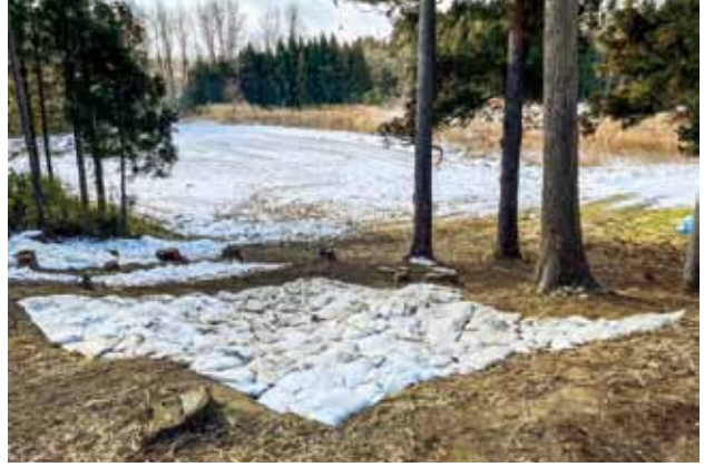
7号トレンチ埋戻後近景
