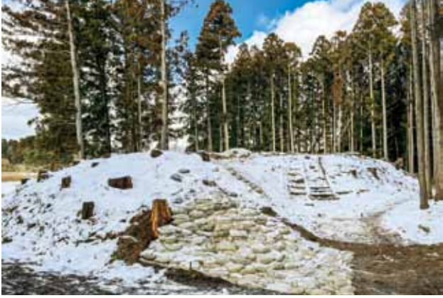
6号トレンチ埋戻後近景
