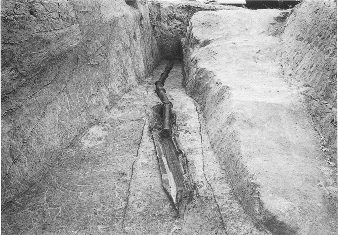
100調査区樋検出状況（東から）
