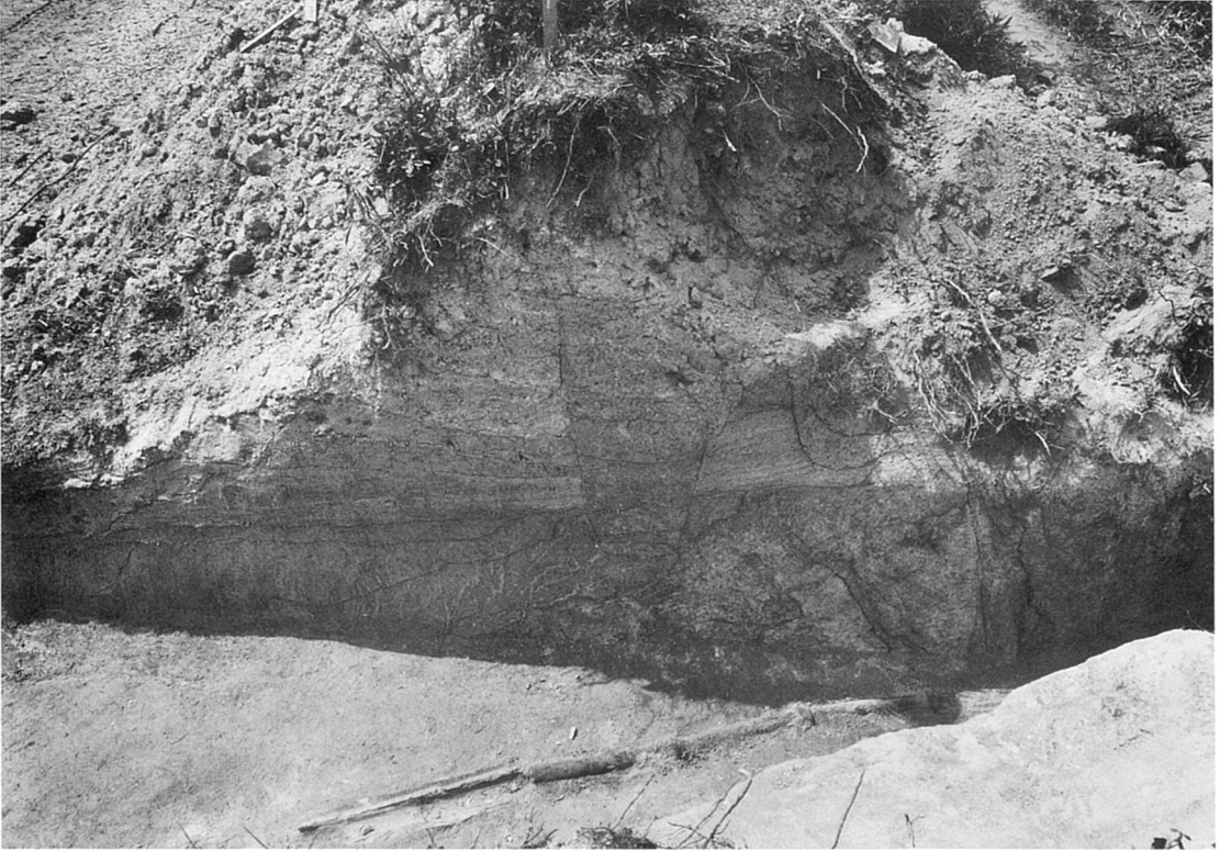
100調査区断面（北から）
