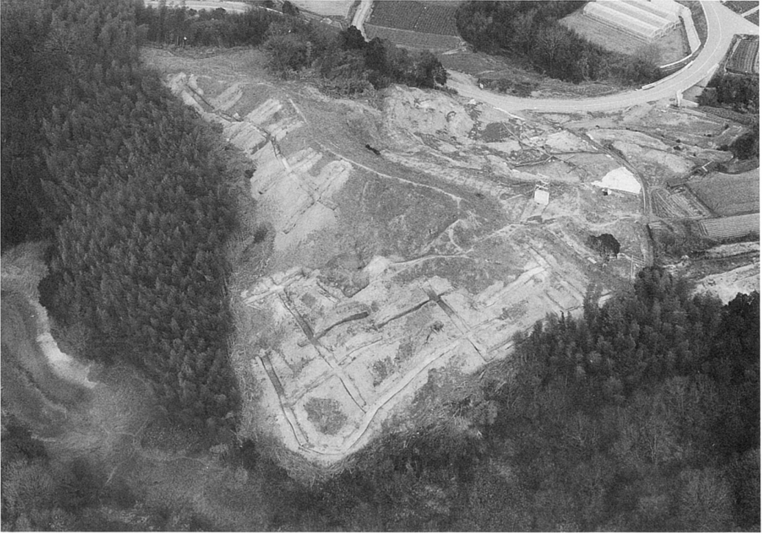
尾根西側斜面部全景（南から）
