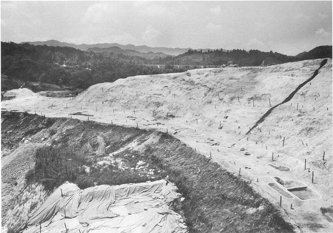
22調査区全景（北から）
