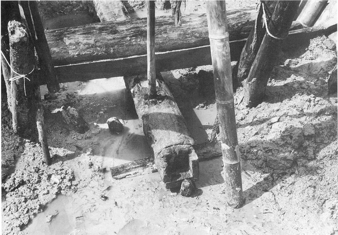
68調査区青池3の樋（南から）
