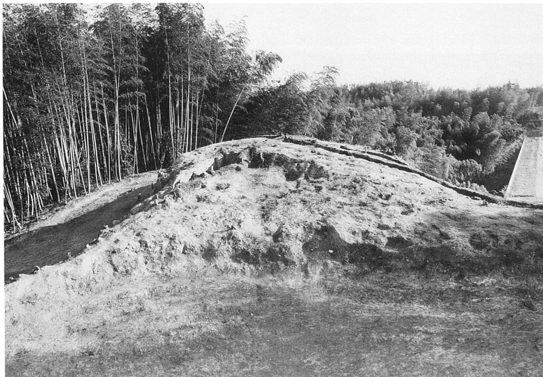
腐植土除去後（西から）
