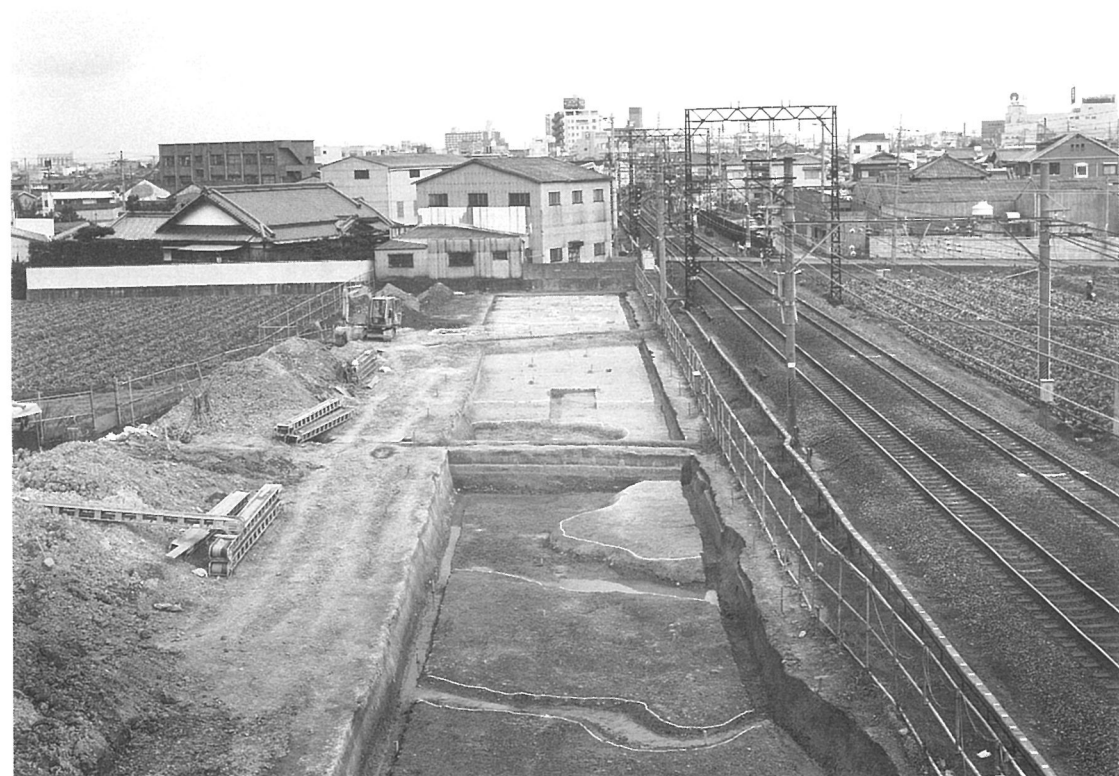
A-2・B-2・C-2区 (南西から)
