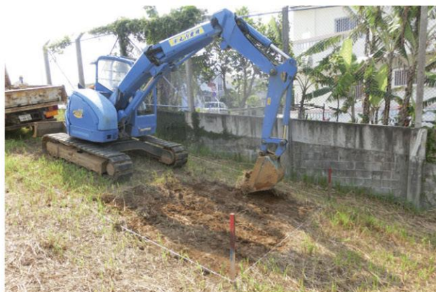
重機による表土掘削
