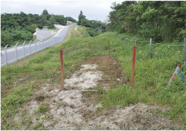
着手前状況〔南西から〕
