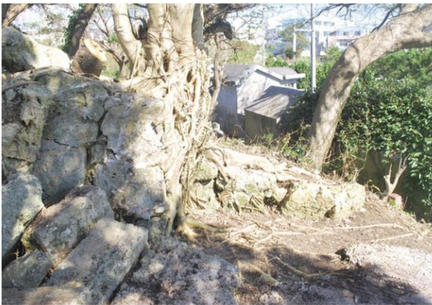
袖石 庭積み検出状況〔西から〕
