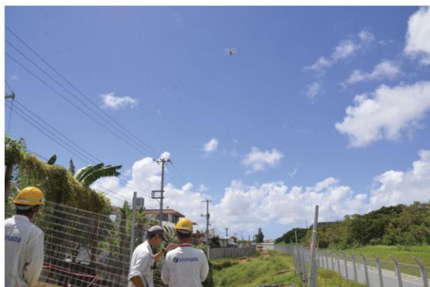
ドローンによる写真測量
