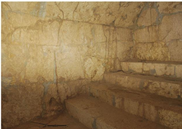
墓室内 掘削前現況〔東から〕
