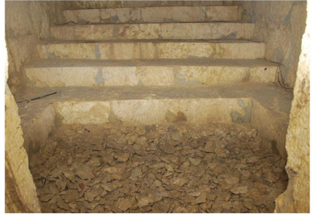
墓室内 掘削前現況〔北から〕
