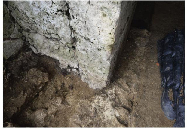
三味台 掘削状況〔東より〕
