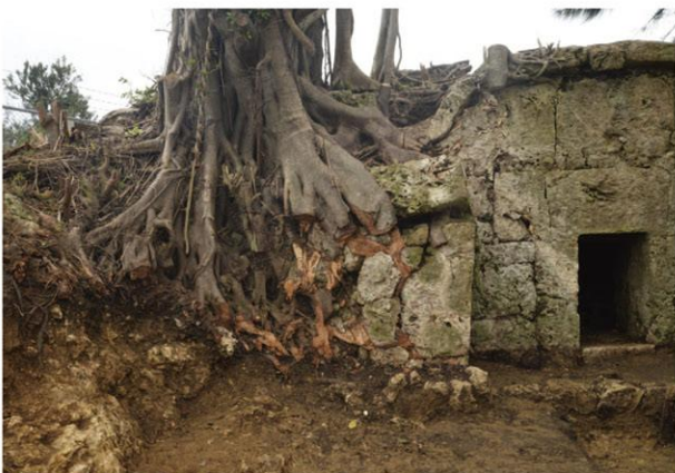
右袖石 検出状況〔南から〕
