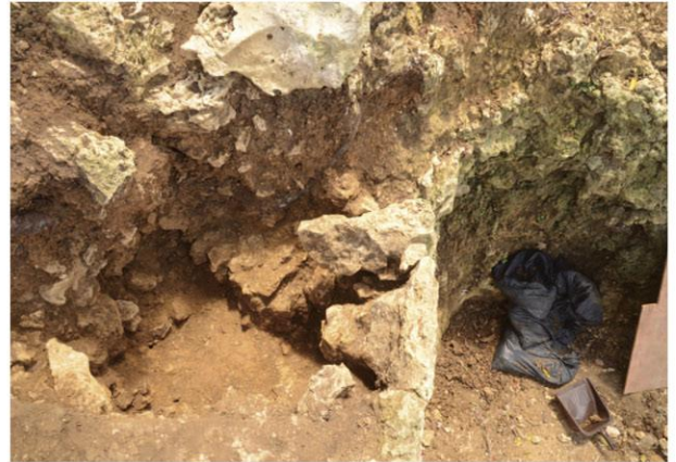
東側袖石石積み岩盤状況〔略南西より〕
