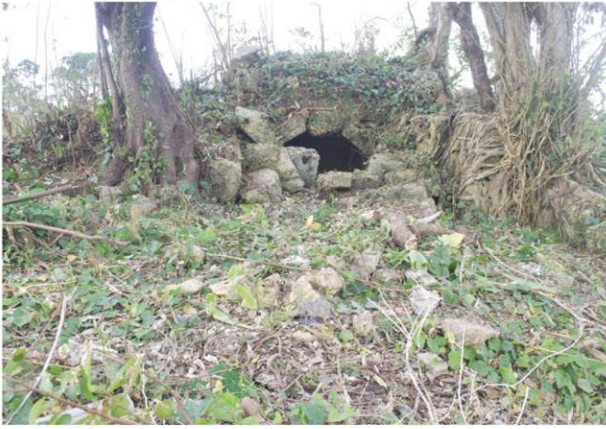
着手前状況〔南から〕
