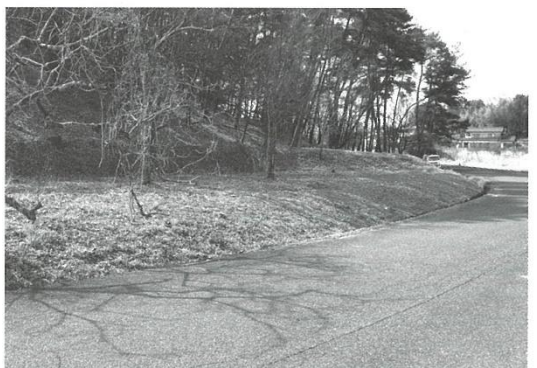
第56図版 作山段の掘削状況
