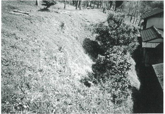
第28図版 一段目平坦面上の民家裏側掘削状況
