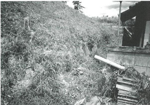
第45図版 民家裏側の掘削状況
