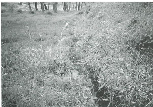
第63図版 墳端の掘削状況
