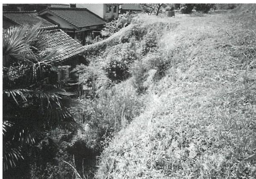
第39図版 民家裏側の掘削状況
