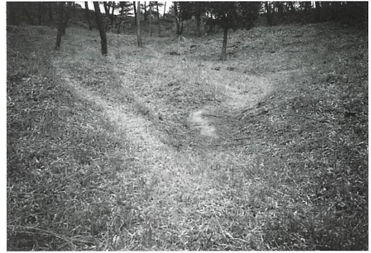
第2図版 くびれ部付近一段目斜面の道と崩落状況
