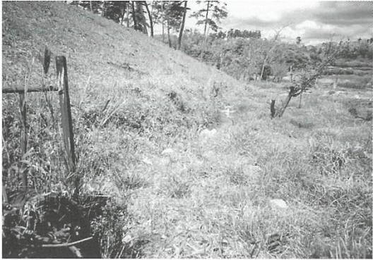
第51図版 後円部墳端付近の掘削状況
