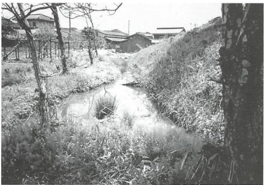
第53図版 墳端の掘削状況
