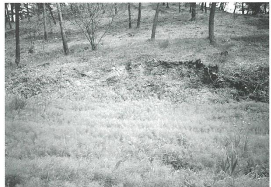
第62図版 一段目の掘削状況
