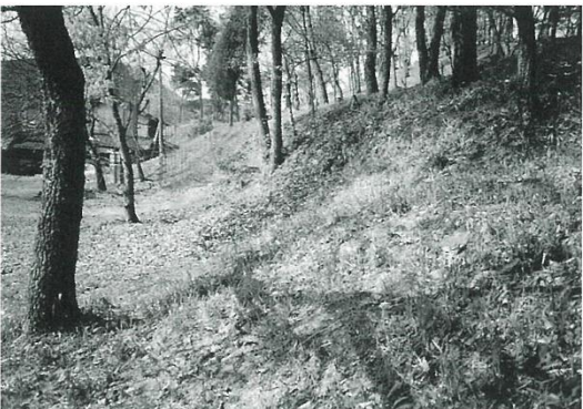
第31図版 二段目斜面の崩落状況
