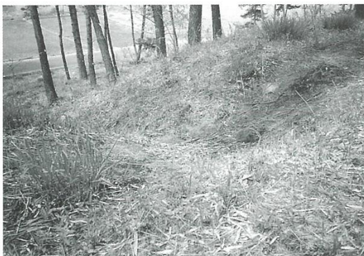
第61図版 二段目以下の道と崩落状況
