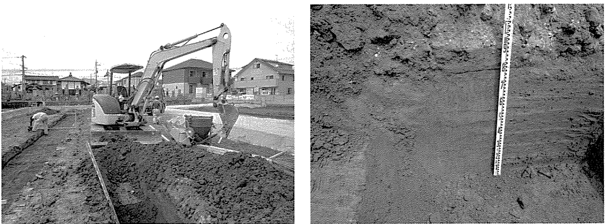
第56図版 調査状況と土層 左：南から 右：西から
