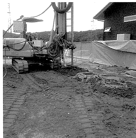
第55図版 ④ 施工状況（北から）
