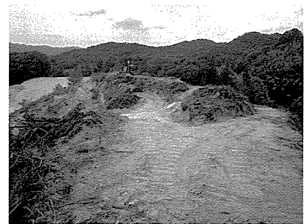
第18図版 調査状況 上：西側斜面 (南から) 下：尾根線 (北から)
