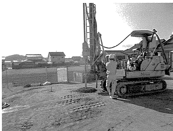
第64図版 掘削状況
