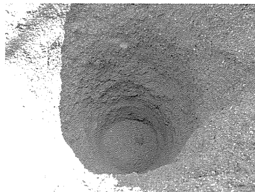
第9図版 ⑦ 先掘り状況
