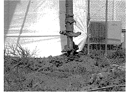
第103図版 ② 掘削状況
