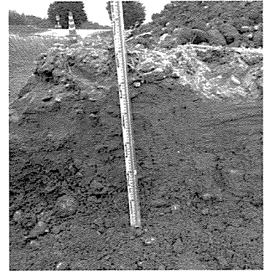
第42図版 北擁壁の南面 (北から)
