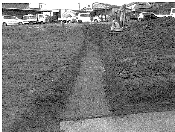
第68図版 掘削状況
