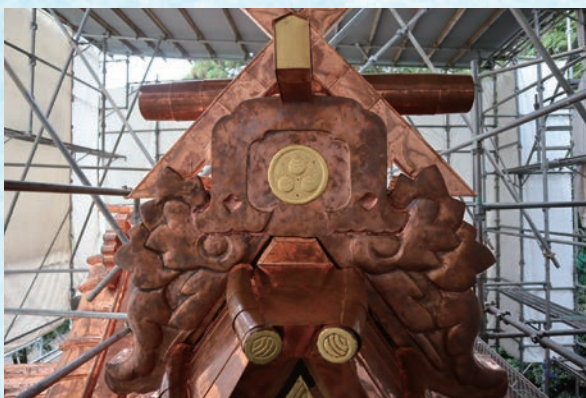
復元した大屋根鬼板飾り（屋根東面・東から）
