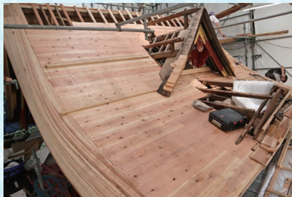
屋根下地修復状況（南西から）
