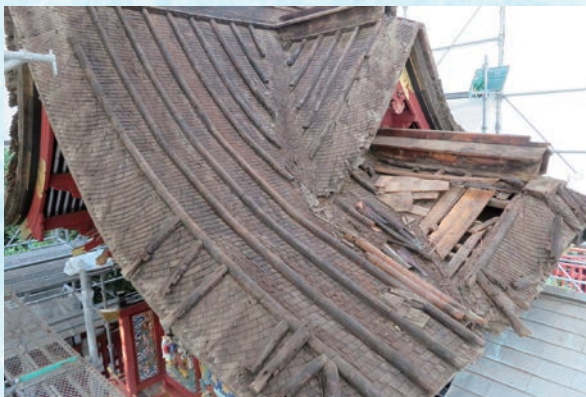
古い銅板を撤去した屋根（屋根南面・南西から）
