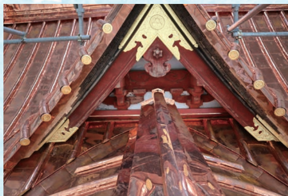
修復後の千鳥破風屋根（屋根南面・南から）
