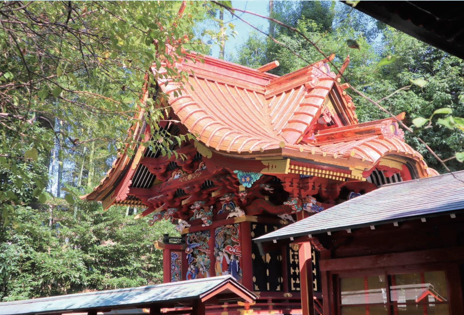
修復後の冠稲荷神社本殿（南西から）
