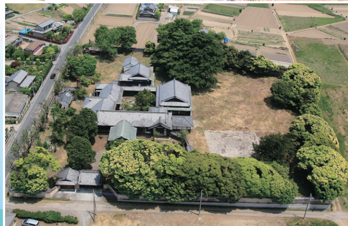
中島知久平邸全景（西上空から）
