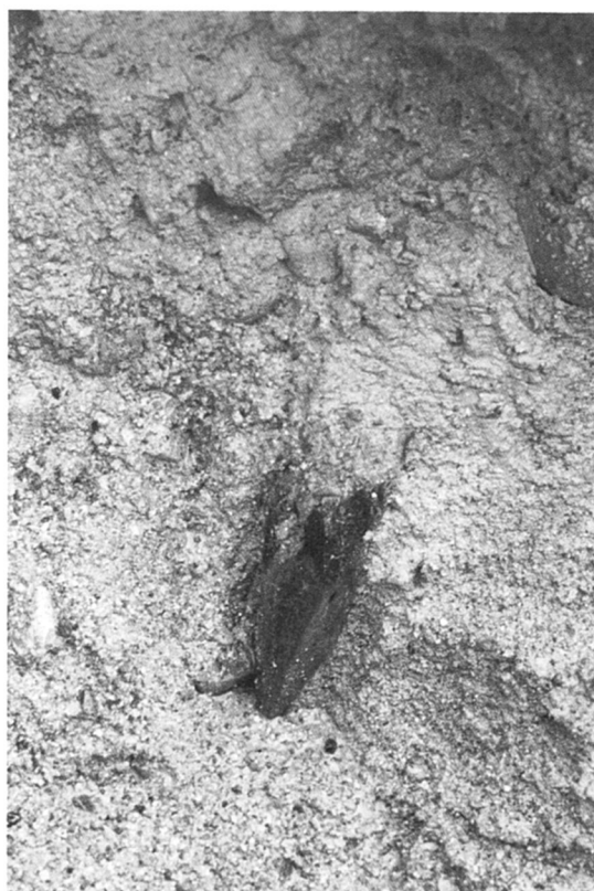
b. 自然河川肩部杭
