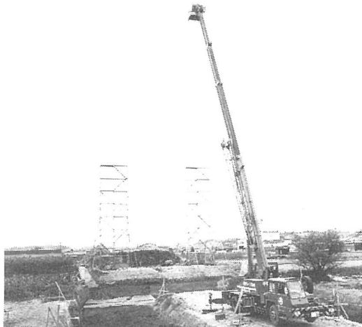
写真2 レッカーによる空測風景
