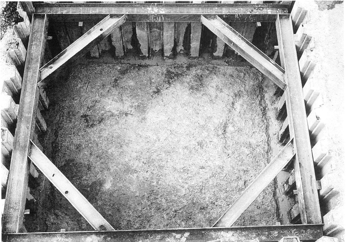
I区完掘（北から）
