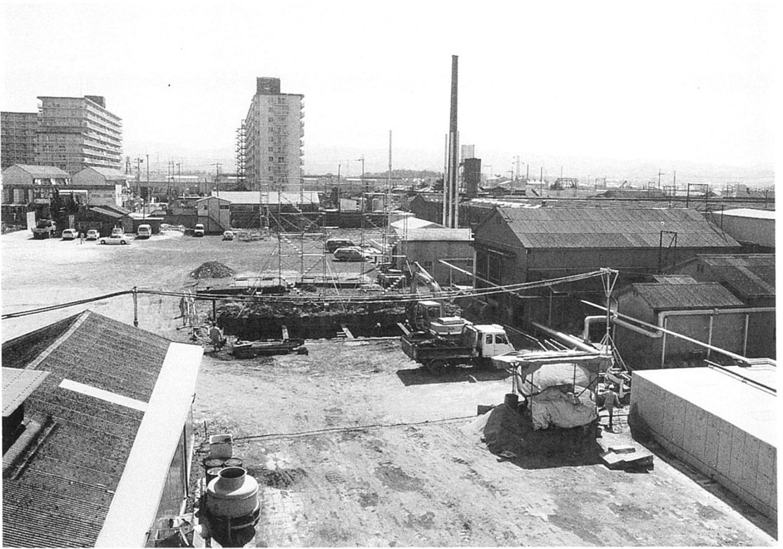
調査対象地全景（西から）
