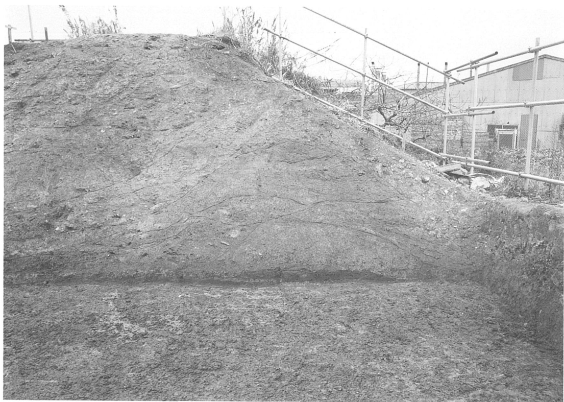
堤No. 4 芯部分
