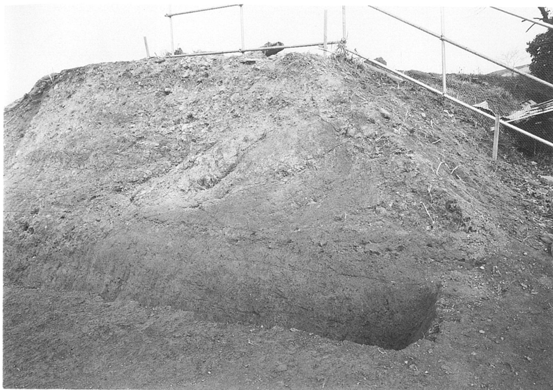
堤No. 3 芯部分
