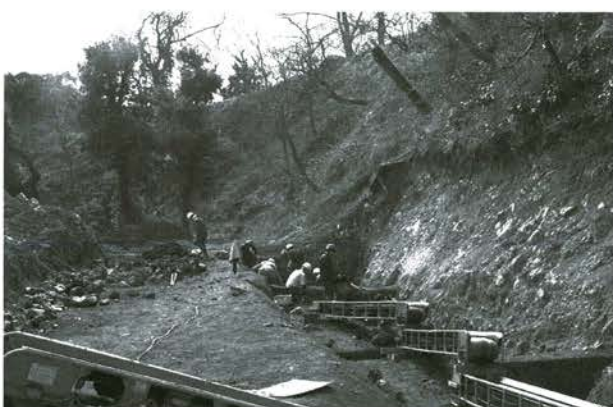
6. I区2溝作業風景
