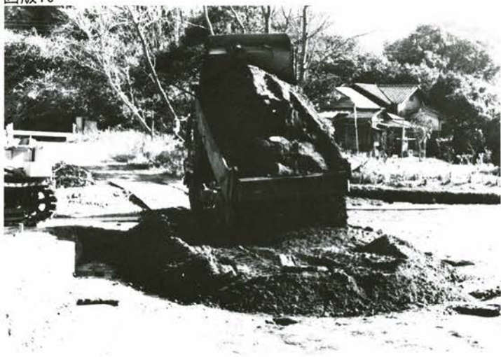
▶ 2 山砂による遺構面の埋め戻し
