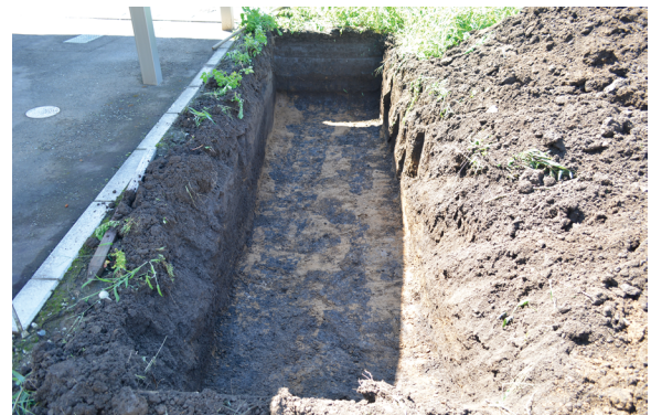
試掘トレンチ (北から)
