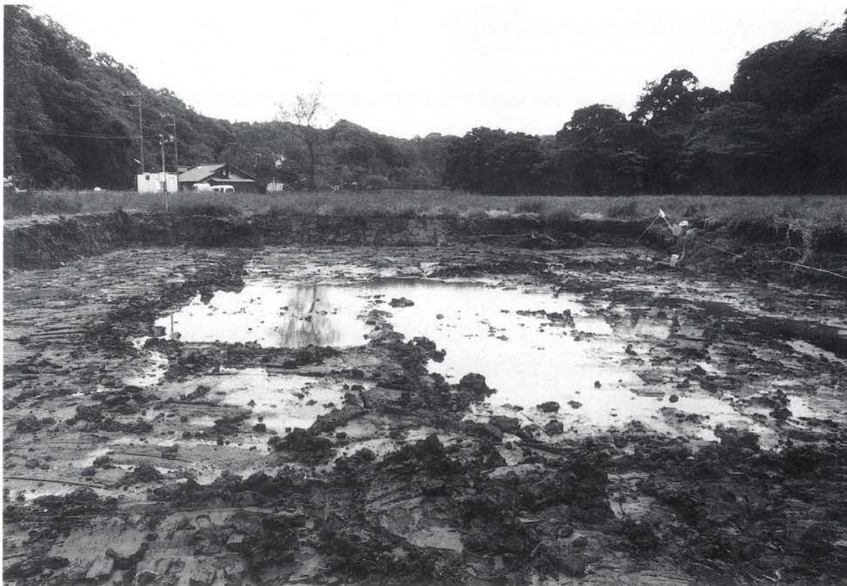
▲1. 重機による掘削終了直後
