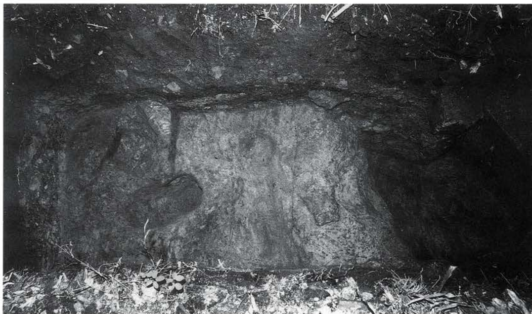
▲1. トレンチ9 土層断面と岩盤面
