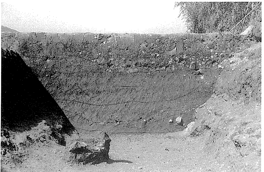
同上南側 SD02土層断面（東より）
