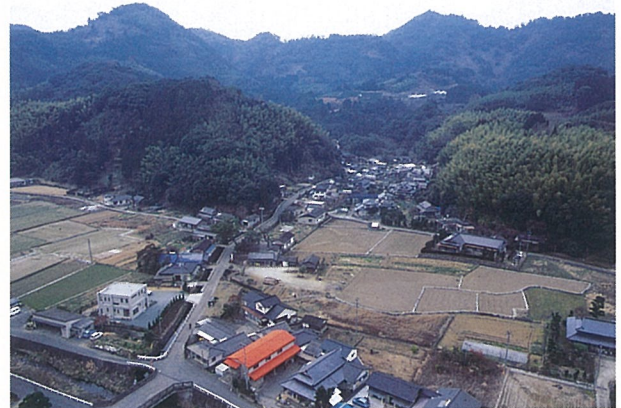
写真7 馬門地区空中写真(東より)
