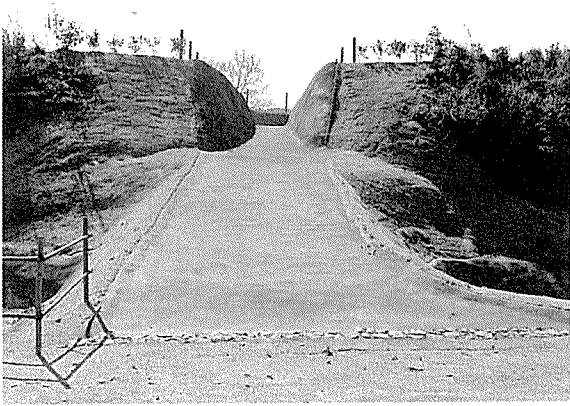
写真11 虎口周辺整備状況（東より）
