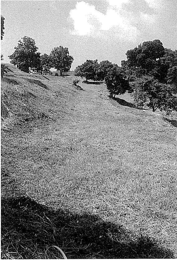
写真3 1701区調査前状況（北より）
