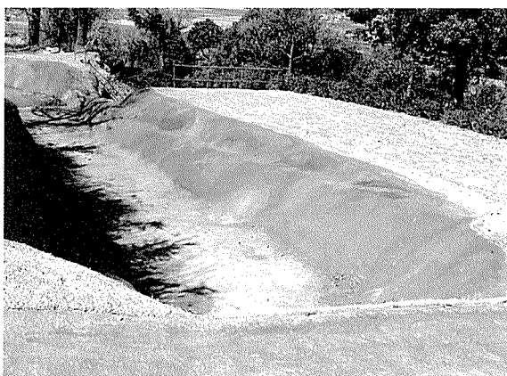
写真9 横堀跡SD02整備状況(南より)
