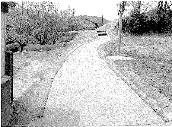
写真13 管理用道路敷設状況（東より）
