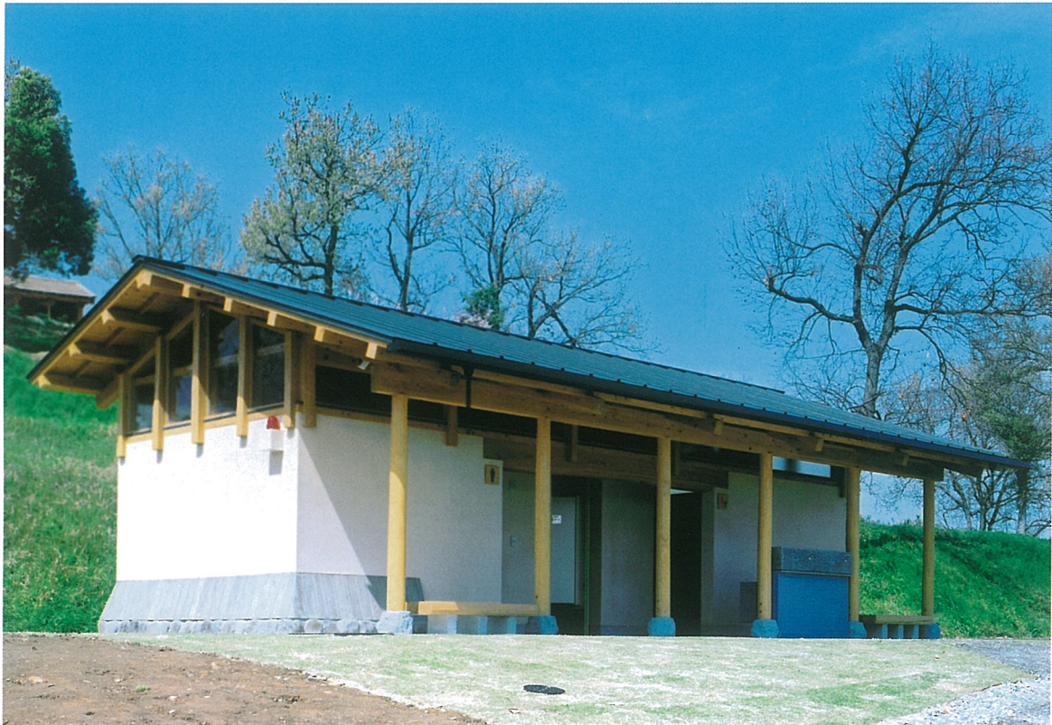
写真16 トイレ竣工写真（東より）
