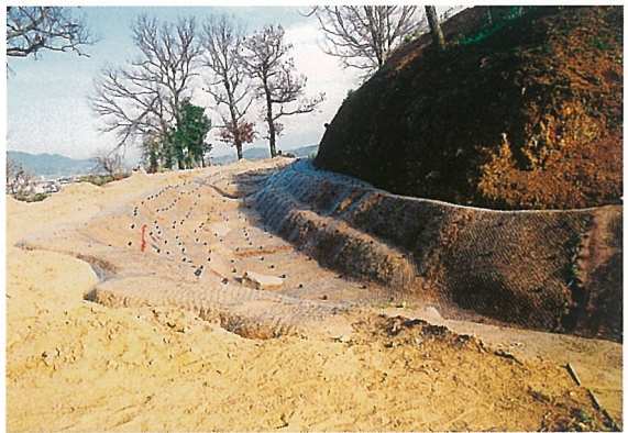
写真19 ラス張り付け状況(西より)
