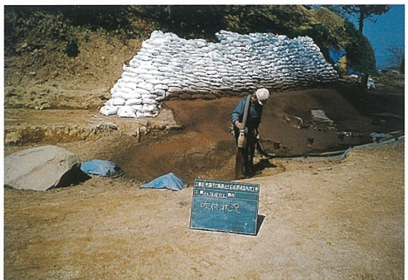
写真28 ソイルセメント吹き付け（南東より）
