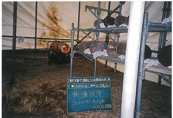
写真26 ジェットヒーターによる石材乾燥
