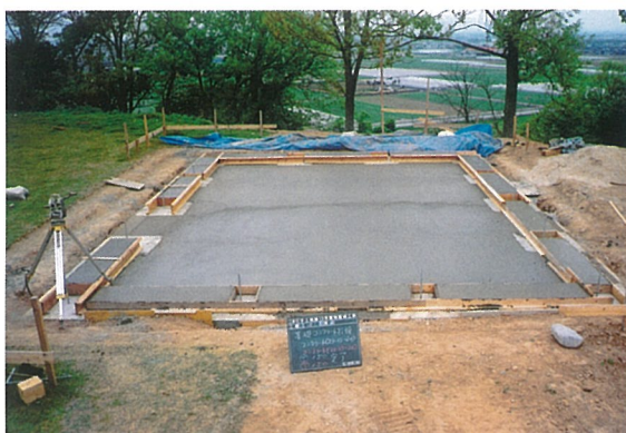
写真29 基礎コンクリート打設
