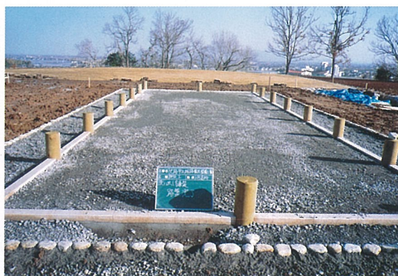
写真26 洗い出し舗装路盤完了状況（16号建物）
