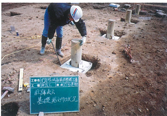
写真25 柱跡表示基礎据付（17号建物）
