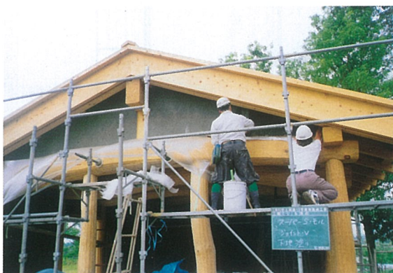
写真31 外壁工事（下地塗り）
