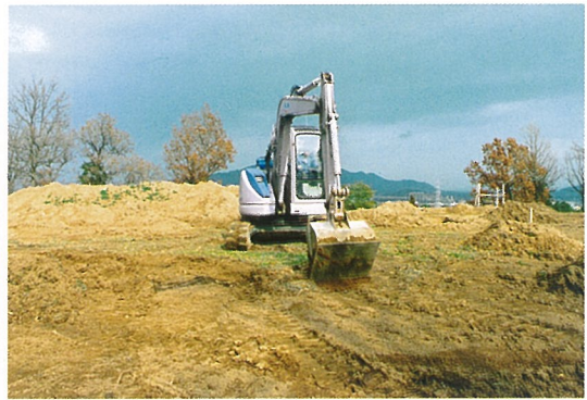
千畳敷表土すき取り状況
