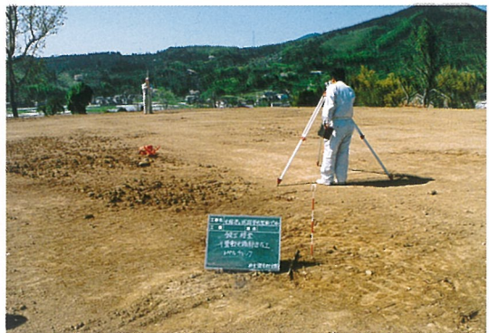
千畳敷保護盛土状況
