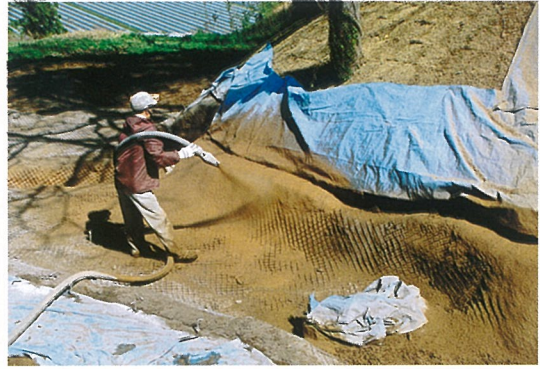
ソイルセメント吹付け状況
