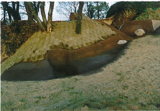
堀・開渠整備状況
