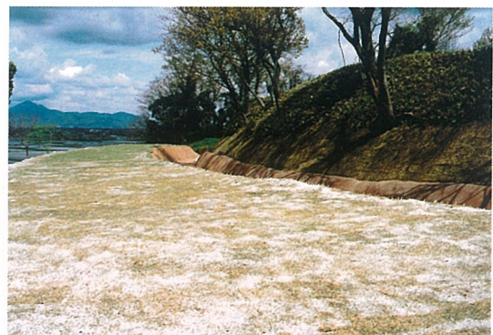
千畳敷西側内堀・平場整備状況
