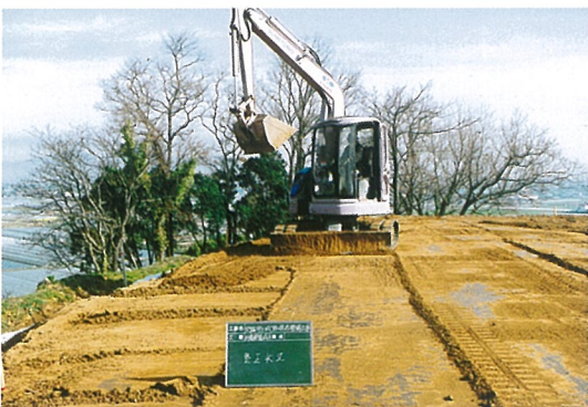
千畳敷保護盛土整形状況
