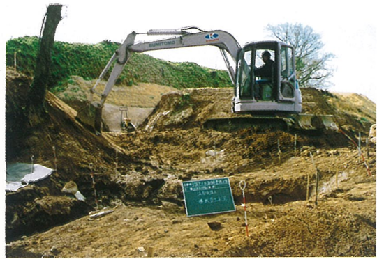
堀・開渠保護盛土状況
