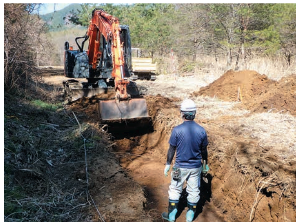
重機によるトレンチ1の掘削
