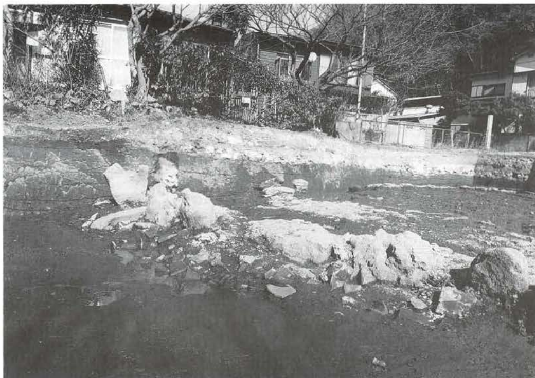
▲ 1. III期苑池汀(南西より)
