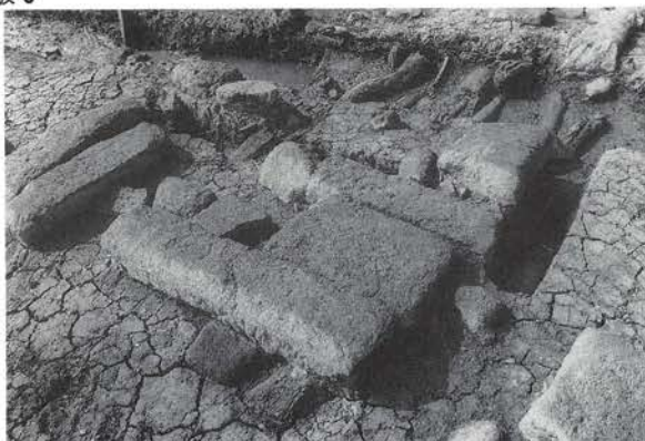
▲ 1. 敷き並べられた石材 基壇に使われた地覆石、葛石等の 部材が見える。
