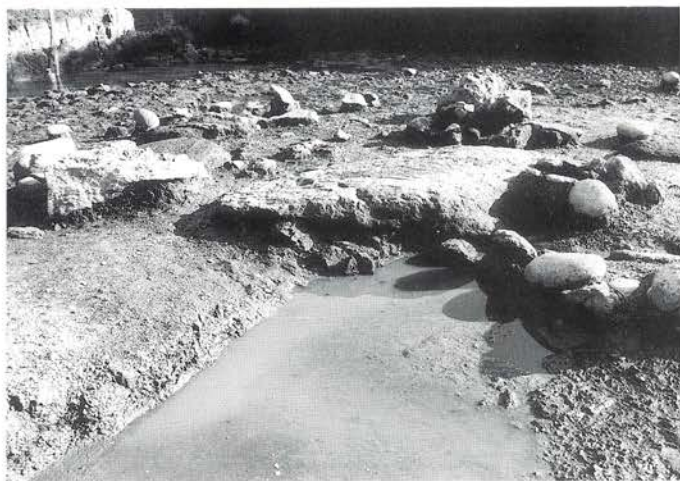
3. 凝灰岩の景石 (土丹・地山土で根がためされる)
