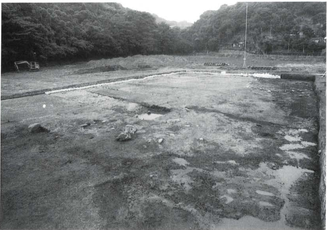
2. 上層調査区 (南東より)
