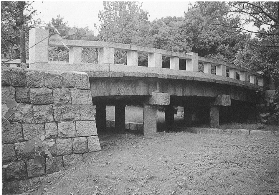
高砂公園に移築された伽羅橋
