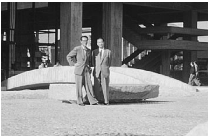
写真34 竣工当時の石テーブル1（神谷宏治氏所蔵） （浮いている下面に注意、人物は神谷（左）、道明栄次（右））
