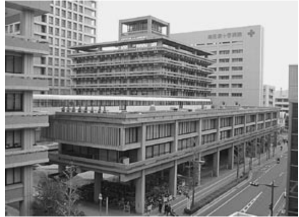
写真39 現在の香川県庁舎旧本館
