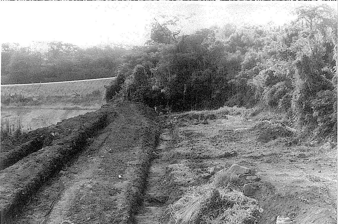
西側トレンチ
