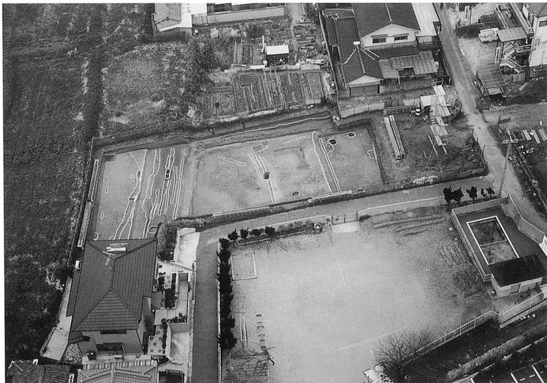
(1) A-1区全景 (航空写真・北から)
