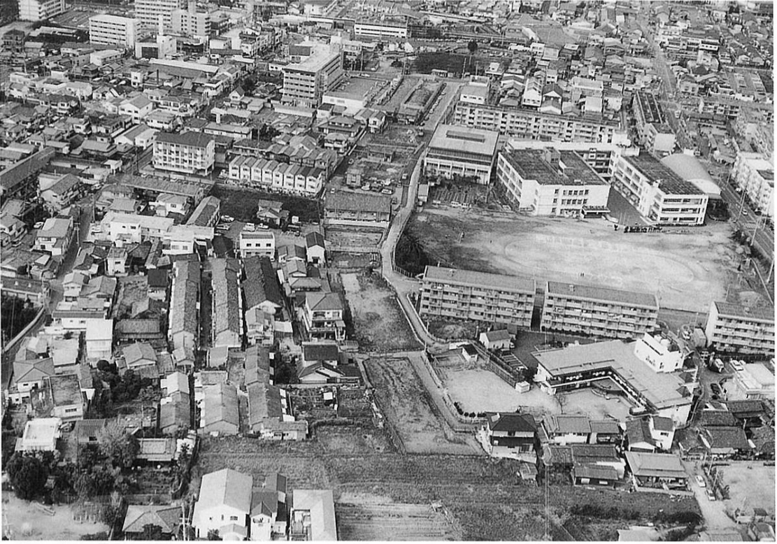
(1) 1993年度調査地全景 (航空写真・東から)
