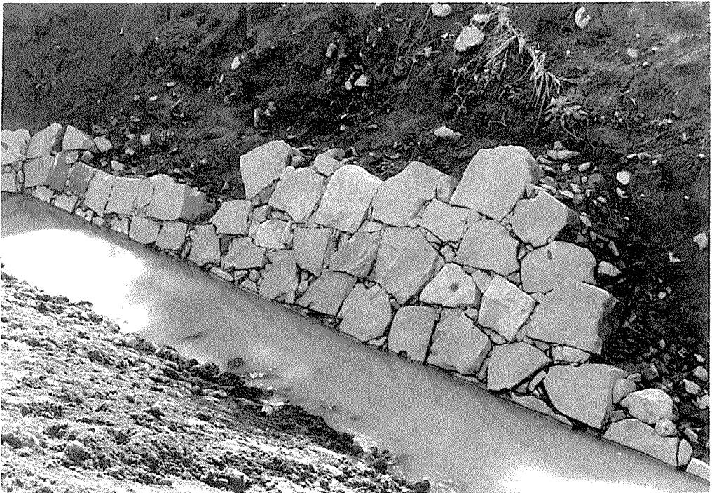
B-T6-b 石垣(北東から)
