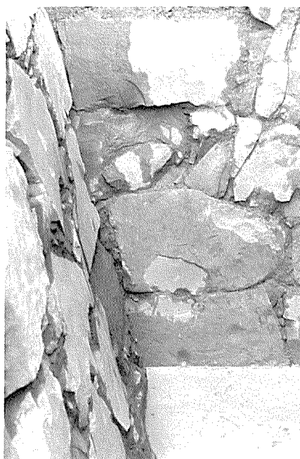
Fig 44 入隅の状態（東より）
