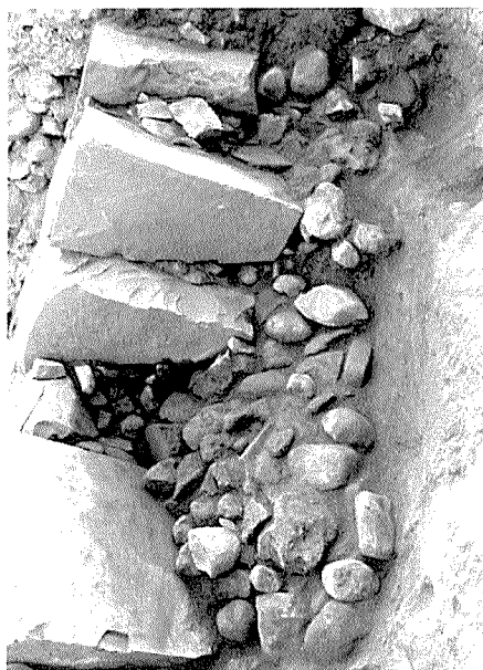
Fig 38 石垣裏込めの状態 (北から)
