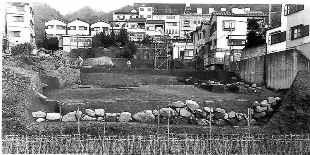
1 D1地区の石垣1 (西より)
