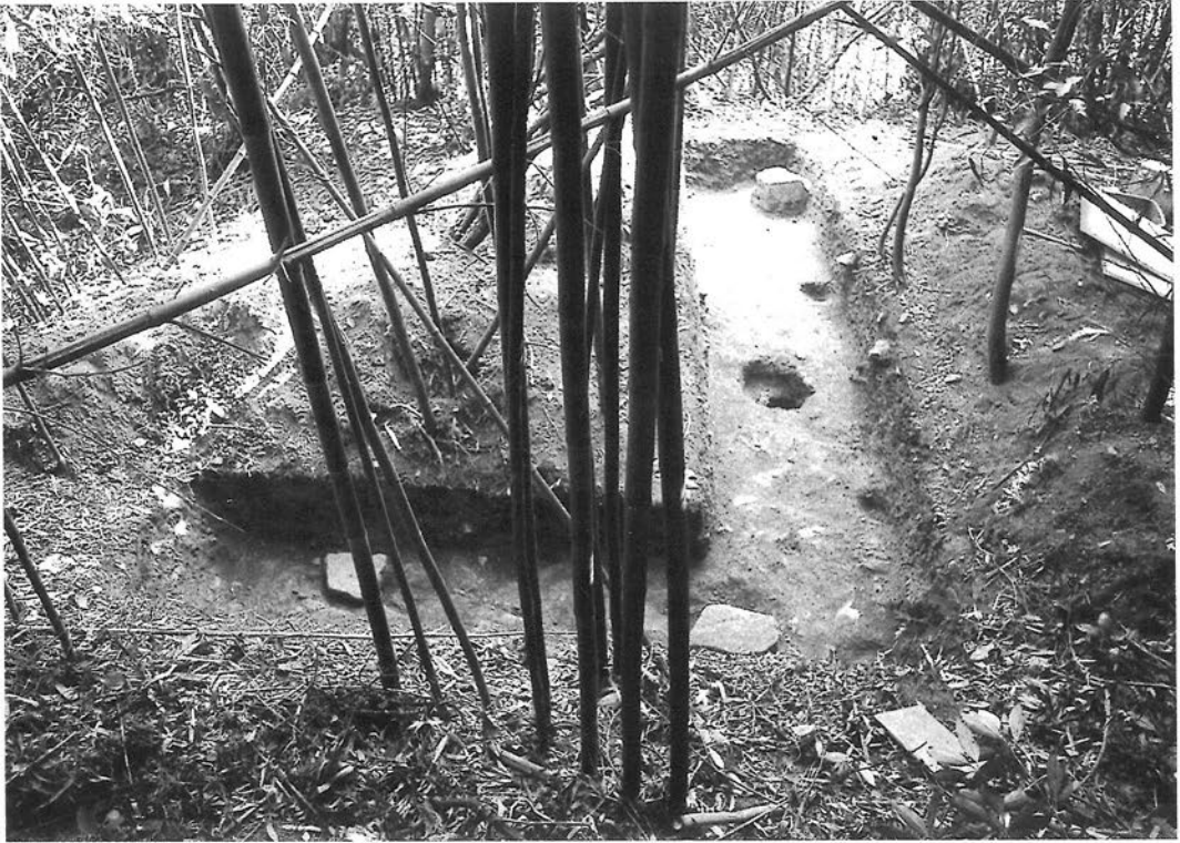
1. 第10トレンチ礎石検出状況
