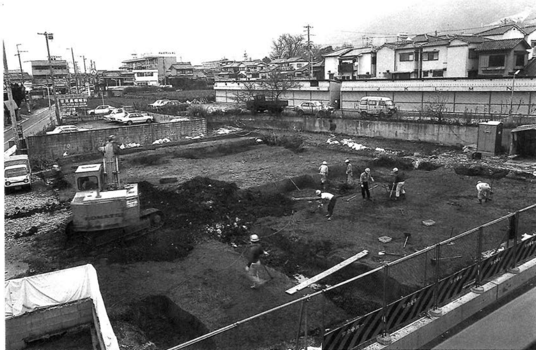
1. 調査風景（南西より）
