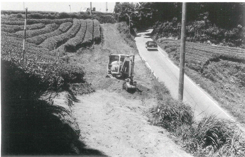
重機稼働風景
