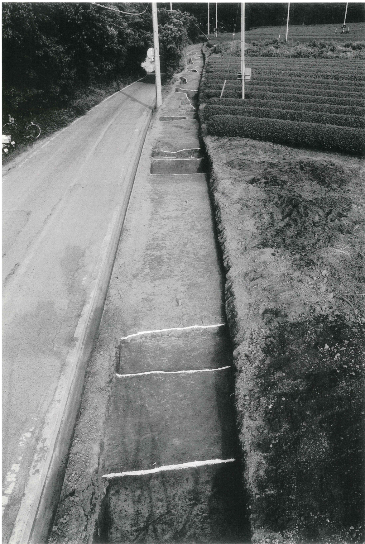
第1区完掘状況（北西から）
