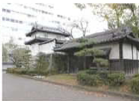
移築された高崎城乾門と東門
