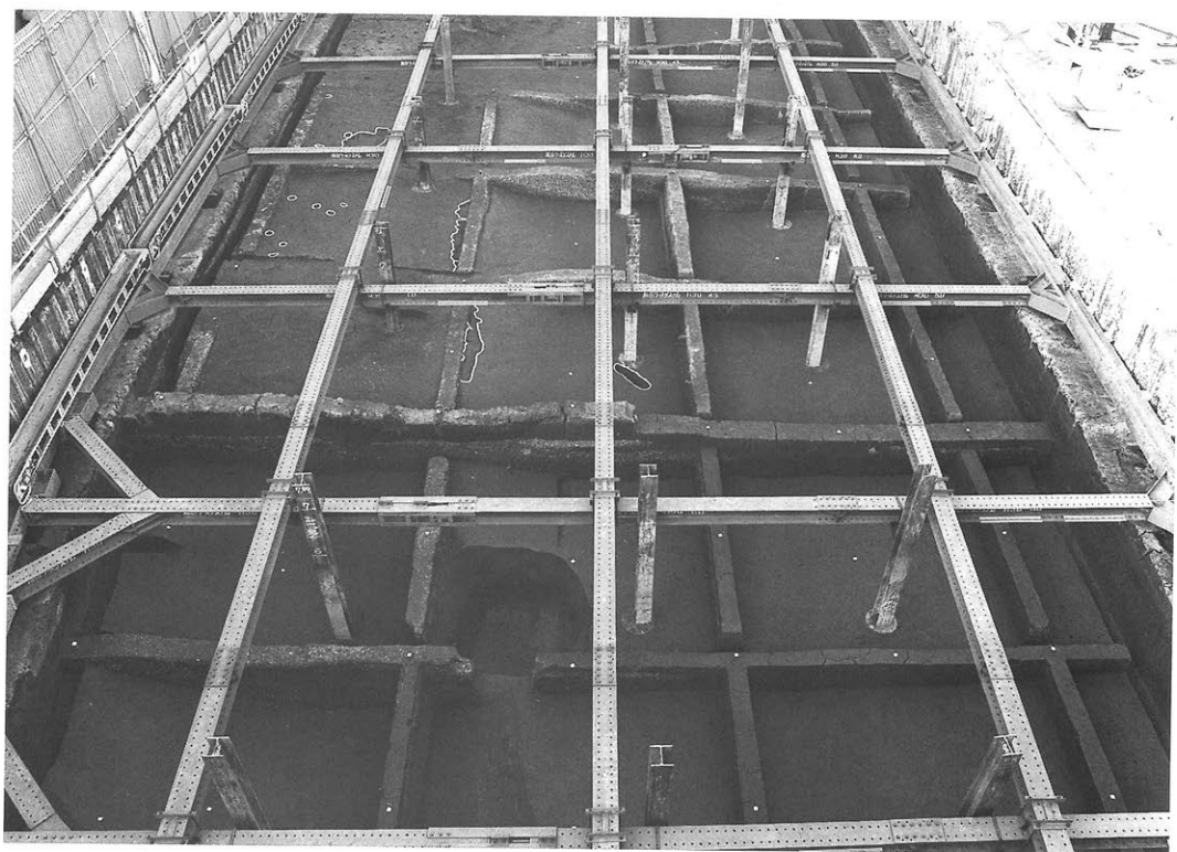
1 貝層1・2下面(南より)
